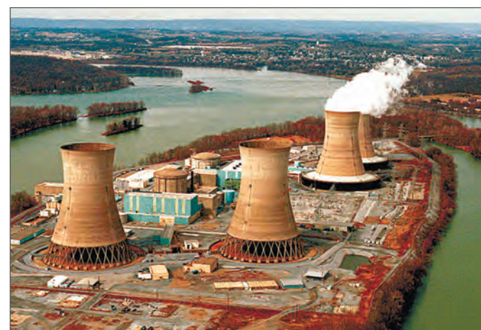
АЭС Три-Майл-Айленд. 28 марта 1979 года на втором энергоблоке станции произошла авария, по причине своевременно не обнаруженной утечки теплоносителя первого контура реакторной установки и потери охлаждения ядерного топлива. Источник фото: britannica.com/event/Three-Mile-Island-accident
