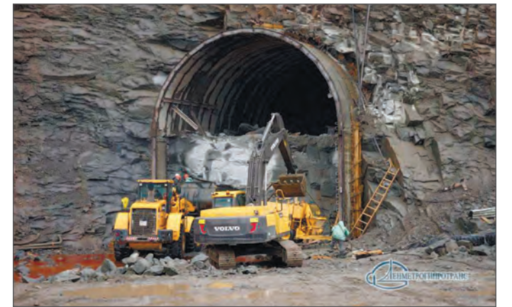
Второй Байкальский тоннель
