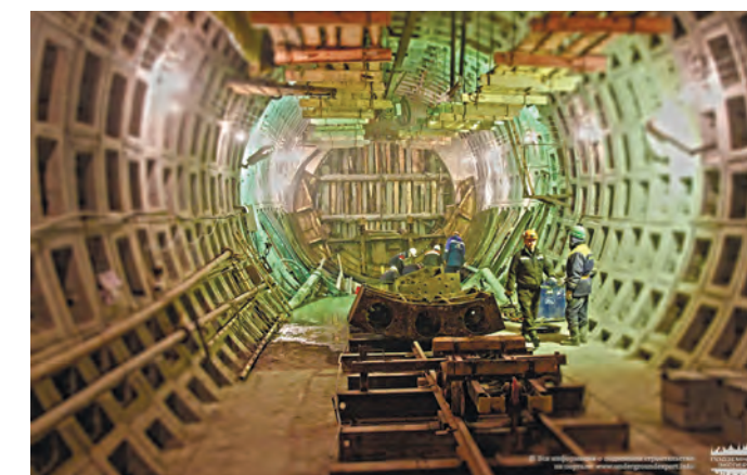
Строительство станции метро «Горный институт» в Санкт-Петербурге
