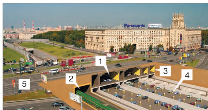
Рис. 9. Общий вид на транспортную развязку под Ленинским проспектом в районе площади Гагарина в Москве: 1 – автотранспортный тоннель; 2 – железнодорожный тоннель; 3 – боковые входы в тоннель; 4 – автомобильная парковка; 5 – Ленинский проспект
