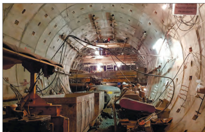
Строительство участка Красносельско – Калининской линии. Фото: ОАО «Метрострой»
