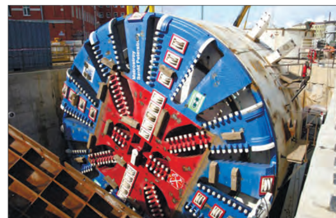
Тоннелепроходческий щит на строительстве петербургского метрополитена
