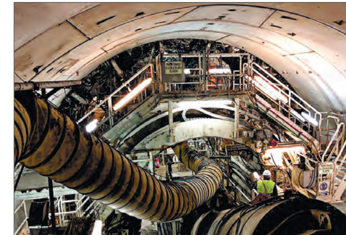
Строительство метро в Барселоне
