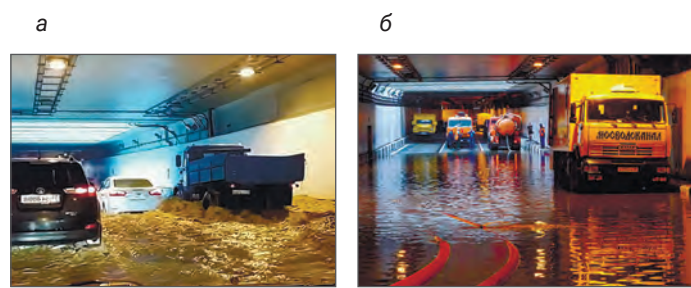
Рис. 8. Затопление проезжей части тоннеля (а) и ликвидация последствий (б)
