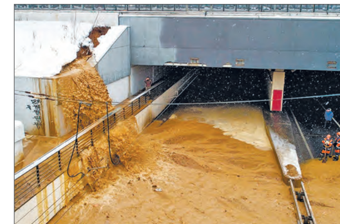
Рис. 2. Поступление воды в Тушинский тоннель из-за прорыва дамбы канала
