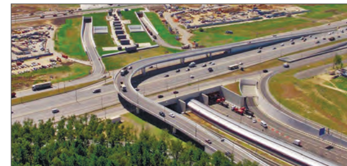
Рис. 10. Совмещенный тоннель под Калужским шоссе
