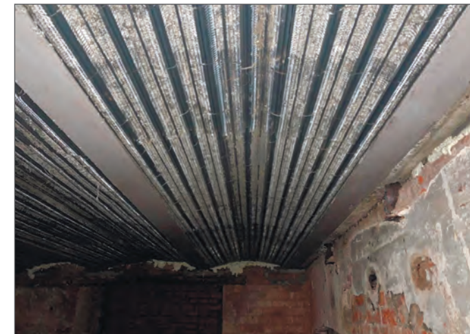
Рис. 4. Итоговая поверхность бетонного свода
