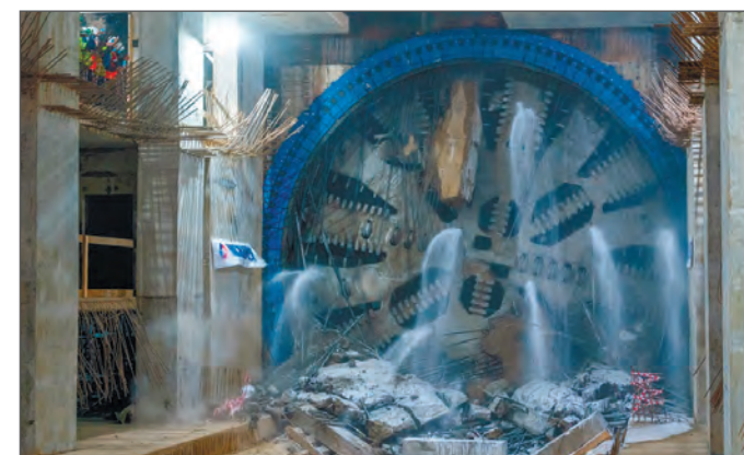
Финиш 10-метрового щита «Лилия» на станции «Кунцевская» БКЛ
