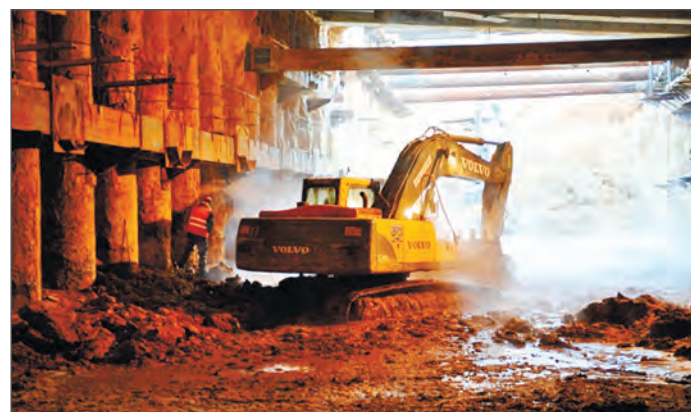
Рис. 7. Разработка водонасыщенного грунта в основании тоннеля
