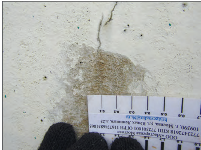
Раскрытие трещины в защитном декоративном слое ребра балки (0,3 мм).
