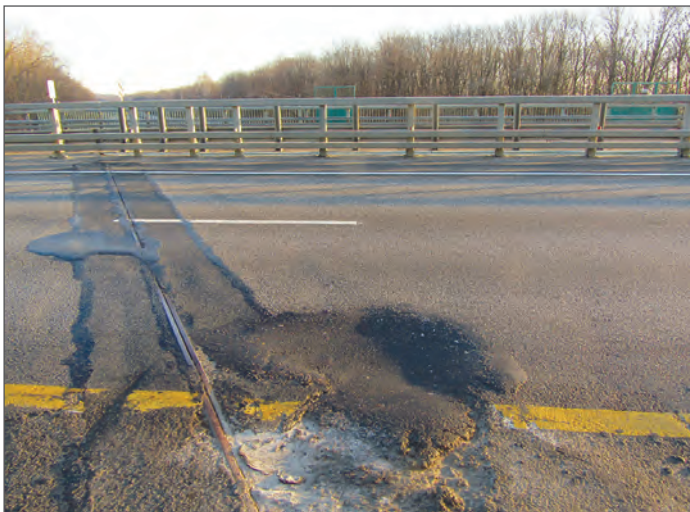
Пролом плиты проезжей части и образование провала асфальтобетона на проезжей части
