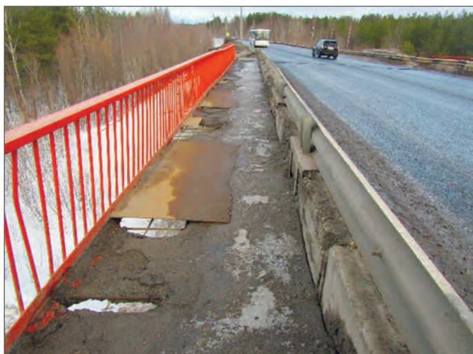
«Ремонт» тротуарных консолей
