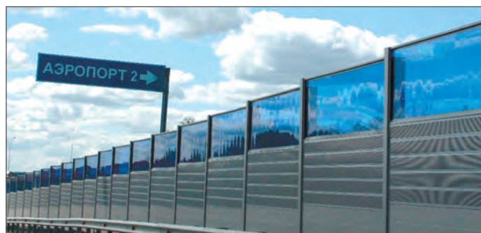
Шумозащитный экран из монолитного поликарбоната Novattro (г. Уфа)
