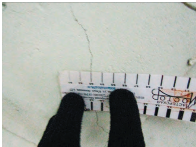
Раскрытие трещины в защитном декоративном слое ребра балки (0,3 мм).
