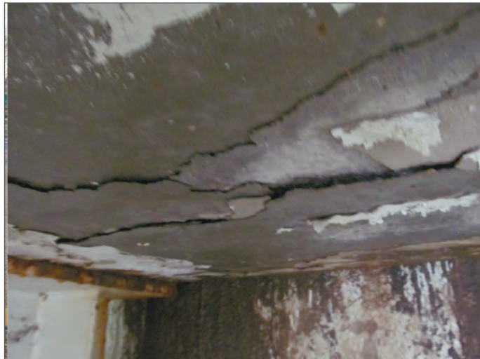
Пролом плиты проезжей части и образование провала асфальтобетона на проезжей части
