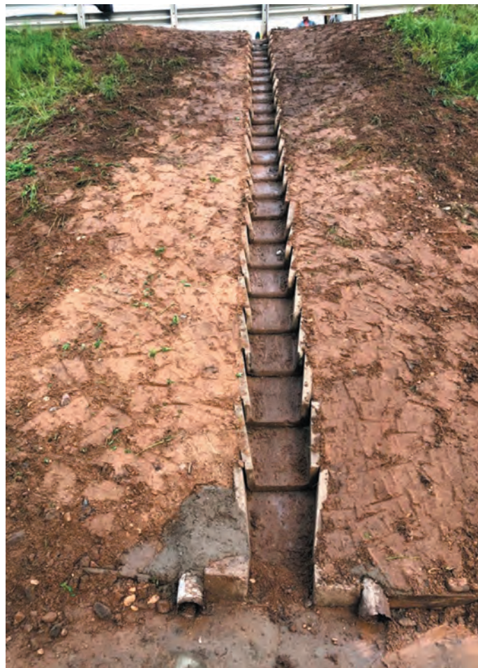
Рис. 5. Общий вид восстановленного поперечного дорожного водоотвода на трассе М-11 «Нева» (уч. 290 км, фото от 10.06.2020)
