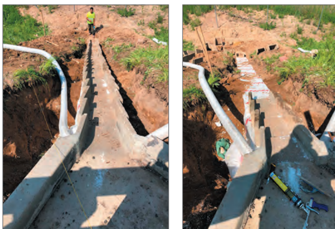
Рис. 4. Монтаж контурного дренажа и бетонных лотков поперечного дорожного водоотвода
