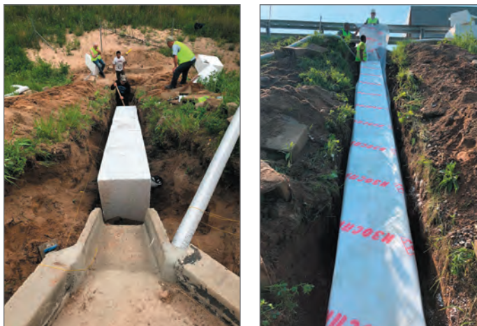
Рис. 3. Устройство основания из блочного пенопласта под лотки поперечного дорожного водоотвода
