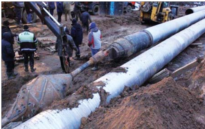
Протаскивание трубопровода с покрытием «ЗУБ-Композит» методом ГНБ
