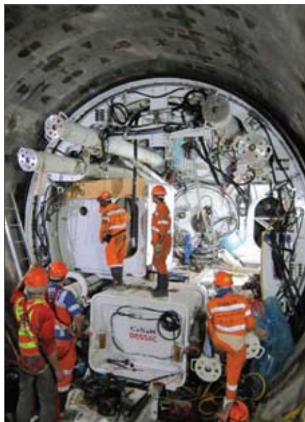
Демонтаж тоннельной обделки
