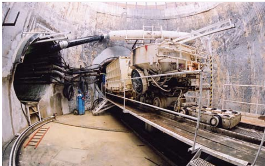
Поворотный стол для строительства тоннелей под острым углом
