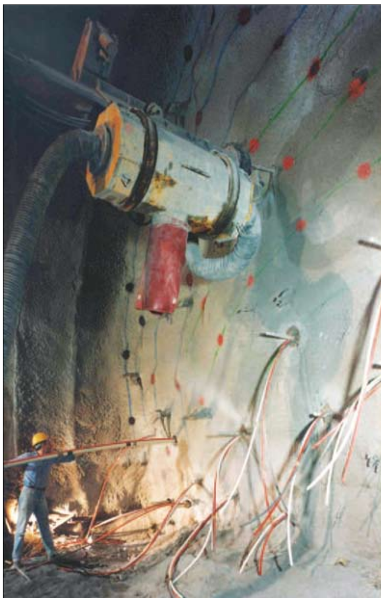
Закрепления ядра забоя стекловолокон- ными трубками (тоннель «Сан Витале»)
