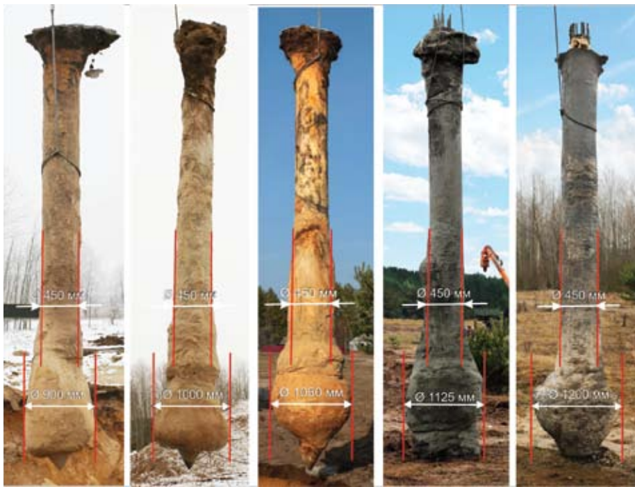
Рис. 3. Бурунабивные сваи с уширением после раскопки
