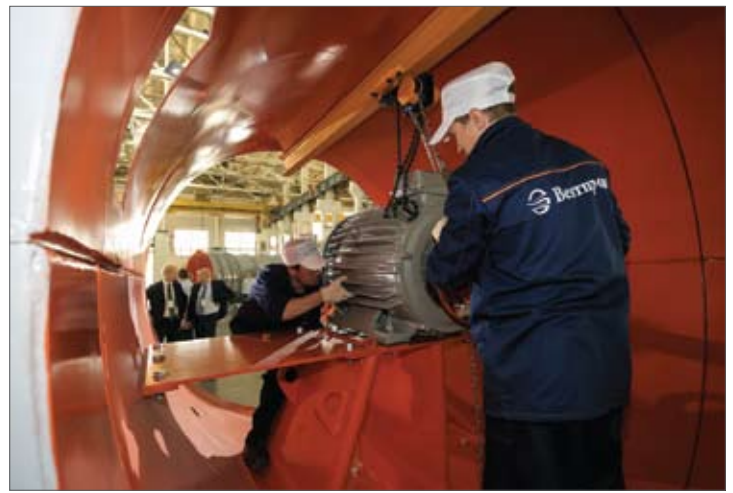
Рис. 5. Демонстрация монтажа роторной группы на заводе
