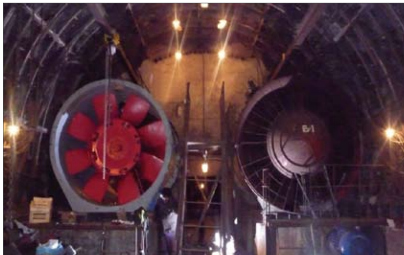
Рис. 2. Модернизация вентилятора в вентиляционной шахте Петербургского метрополитена
