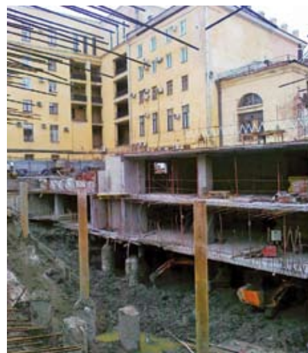
Рис. 12. Процесс разработки котлована методом «полу-топ-даун» (на переднем плане металлические колонны, вмонтированные в буронабивные сваи)
