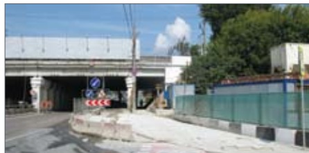
Рис. 5. Организация работ по усилению фундаментов путепровода
