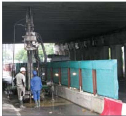
Рис. 4. Производство работ по устройству грунтобетонных элементов
