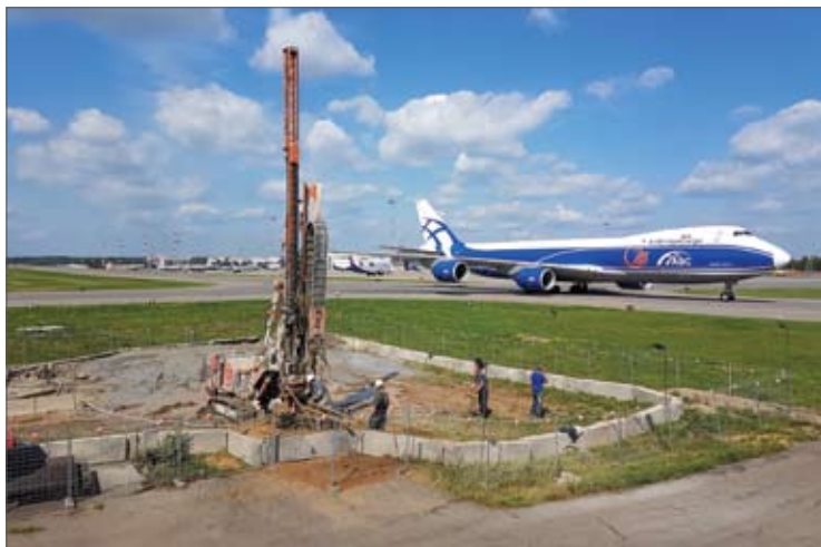
Рис. 5. Производство работ по укреплению грунтов на первой сбойке
