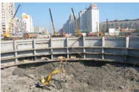
Рис. 5. Устройство обвязочных балок, части перекрытий и поэтажная откопка котлована
