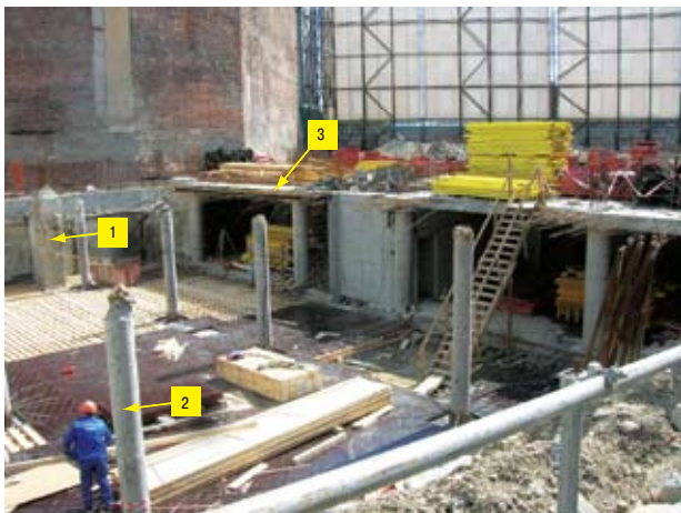
Рис. 9. Процесс разработки котлована на промежуточной стадии: 1 – контрфорс «стены в грунте»; 2 – свая-колонна, выполненная с поверхности методом «Фундекс»; 3 – верхняя плита железобетонного перекрытия паркинга
