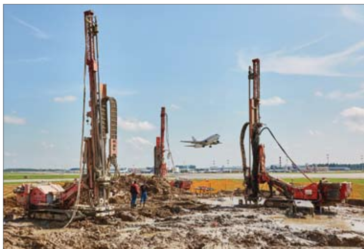
Рис. 6. Производство работ по укреплению грунтов на второй сбойке
