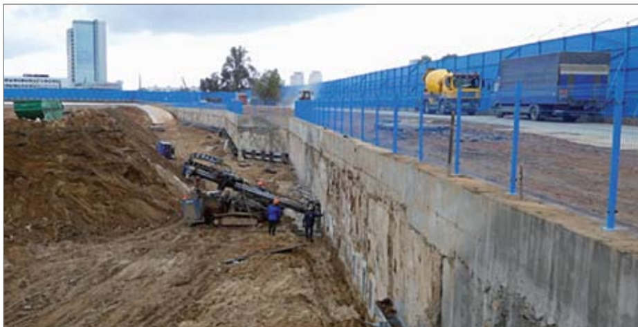
Рис. 2. Анкерование ограждения котлована МФК
