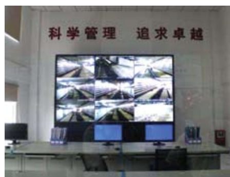
Рис. 8. Центр управления инженерным тоннелем
