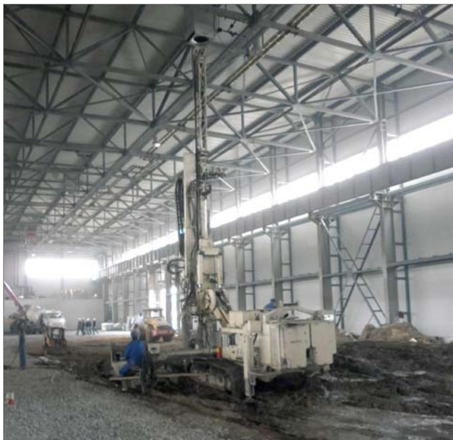
Рис. 1. Работы по устройству грунтобетонных элементов в непосредственной близости от существующих конструкций
