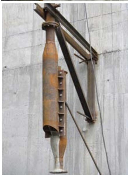
Рис. 1. Подача бетонной смеси в опытный блок с высоты 54 м по трубопроводу, оборудованному на конце гасителем скорости
