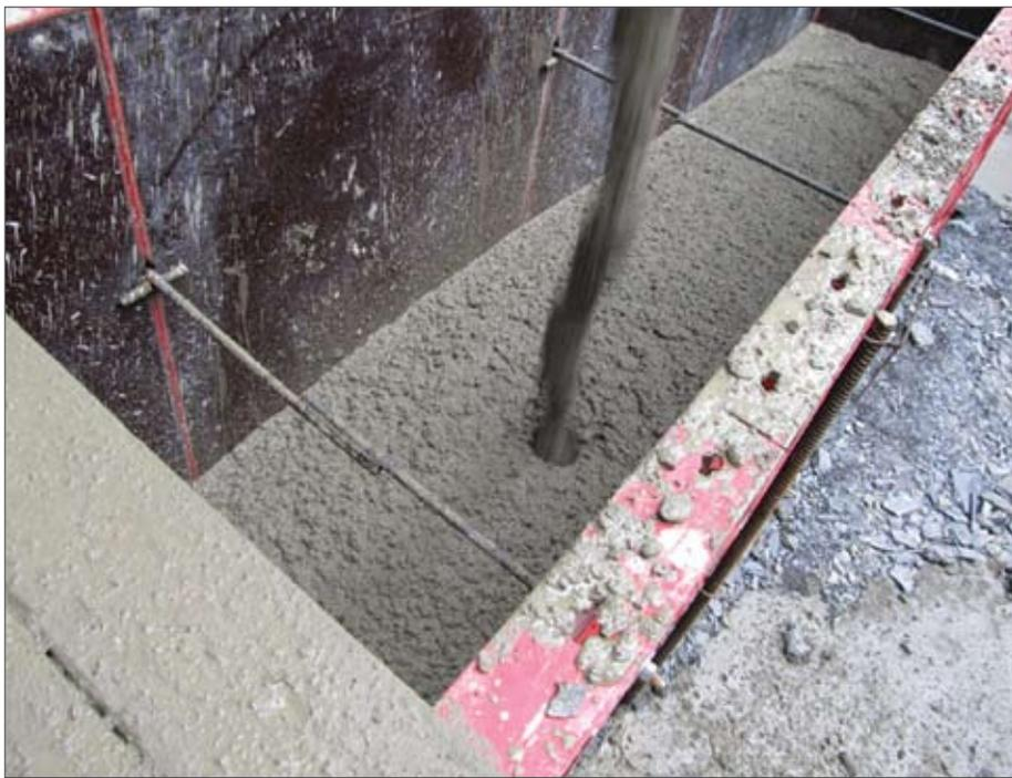
Рис. 2. Загрузка высокоподвижной бетонной смеси в опытный блок с высоты 54 м
