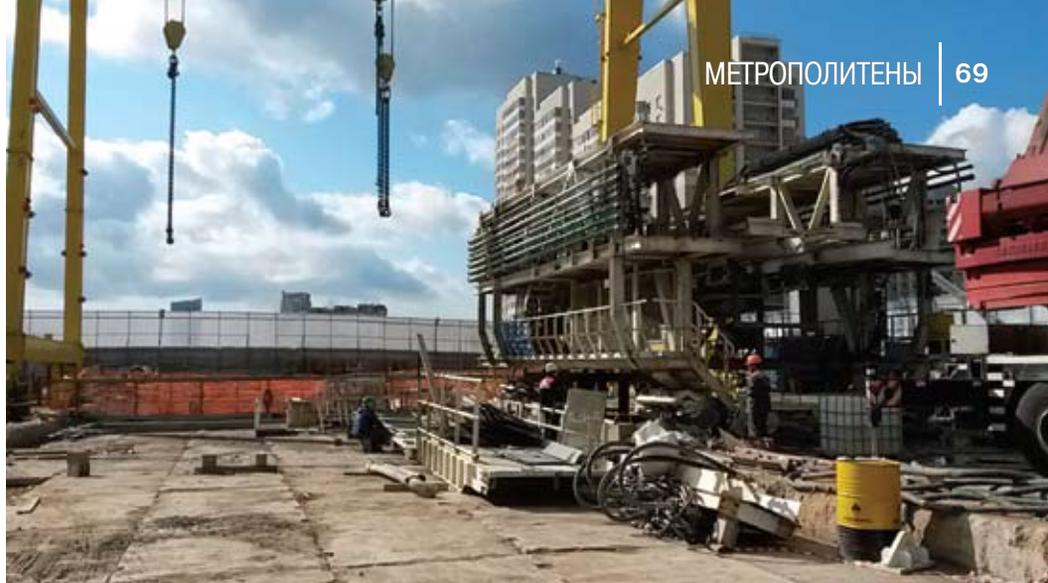
Сборка технологической тележки на поверхности шахты №462
