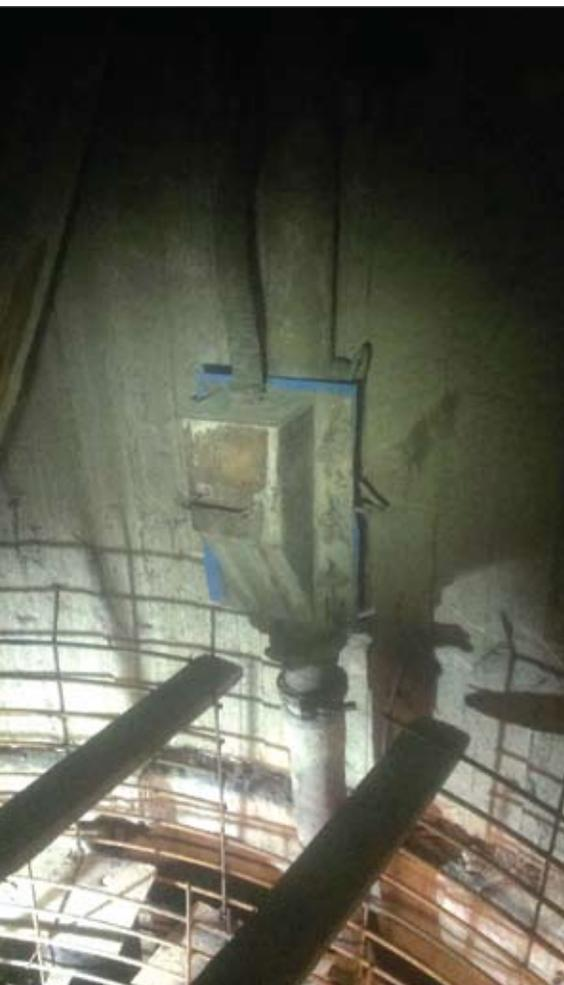
Рис. 3. Гаситель скорости бетонной смеси, усовершенствованная конструкция
