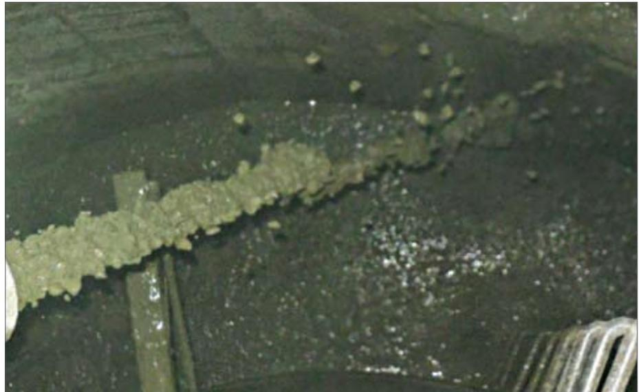
Рис. 4. Внешний вид бетонной смеси при выходе из гибкого шланга
