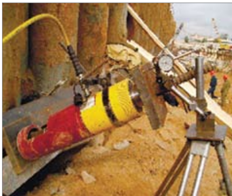
Испытание анкера Серебряноборского тоннеля. Открытый участок
