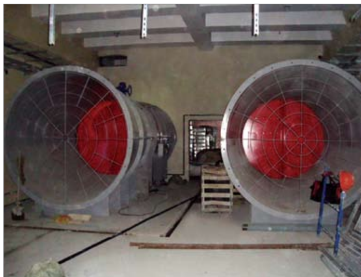
Рис. 5. Монтаж вентиляторов марки Zitron типа ZVN (Санкт-Петербург, станция «Новокрестовская»)
