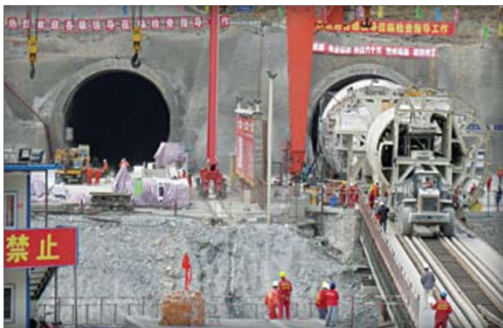
Строительство тоннеля Западного Циньлина
