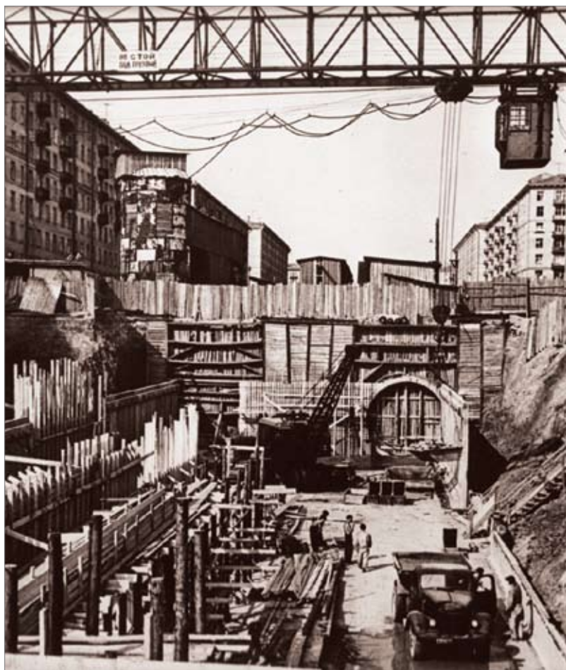
На строительстве Московского метрополитена, 1960 г.
