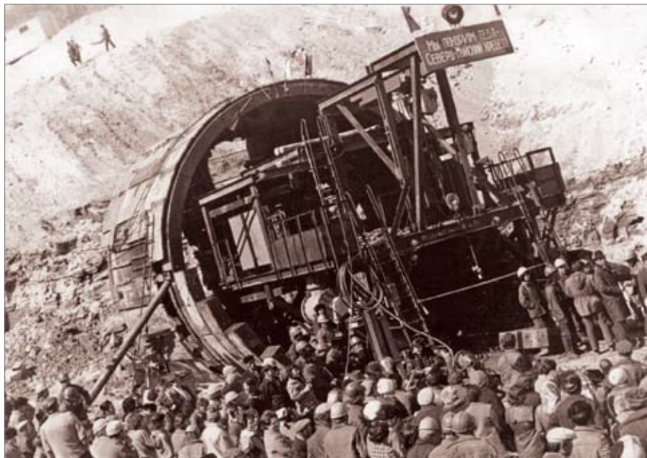
Строительство Северомуйского тоннеля
