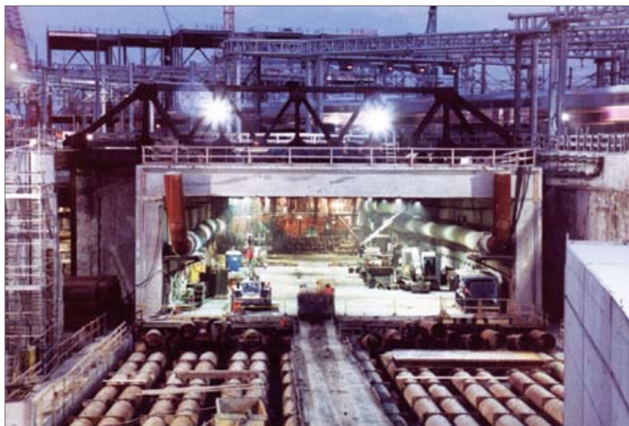
Рис. 4. Домкратное продавливание секции тоннеля Форт Пойнт ( https://www.baminternational.com )
