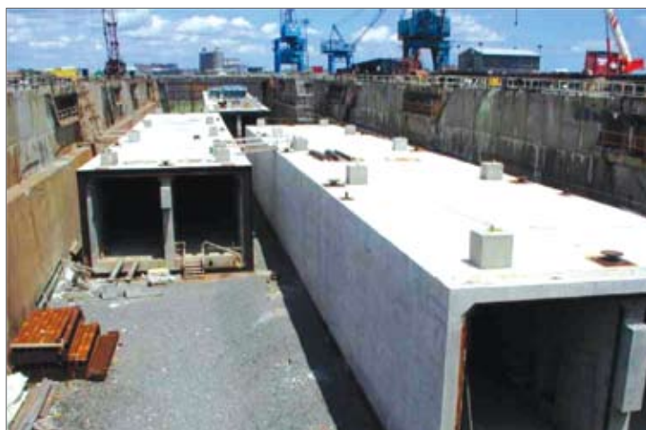
Рис. 10. Бетонные секции тоннеля в сухом доке ( http://www.jennyeng.com )
