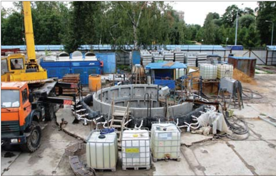
Строительная площадка шахты №571
