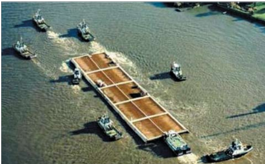
Рис. 3. Транспортировка секции тоннеля к месту установки
