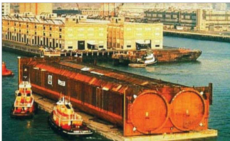
Рис. 8. Транспортировка секций тоннеля Тэда Вильямса ( https://www.slideshare.net )
