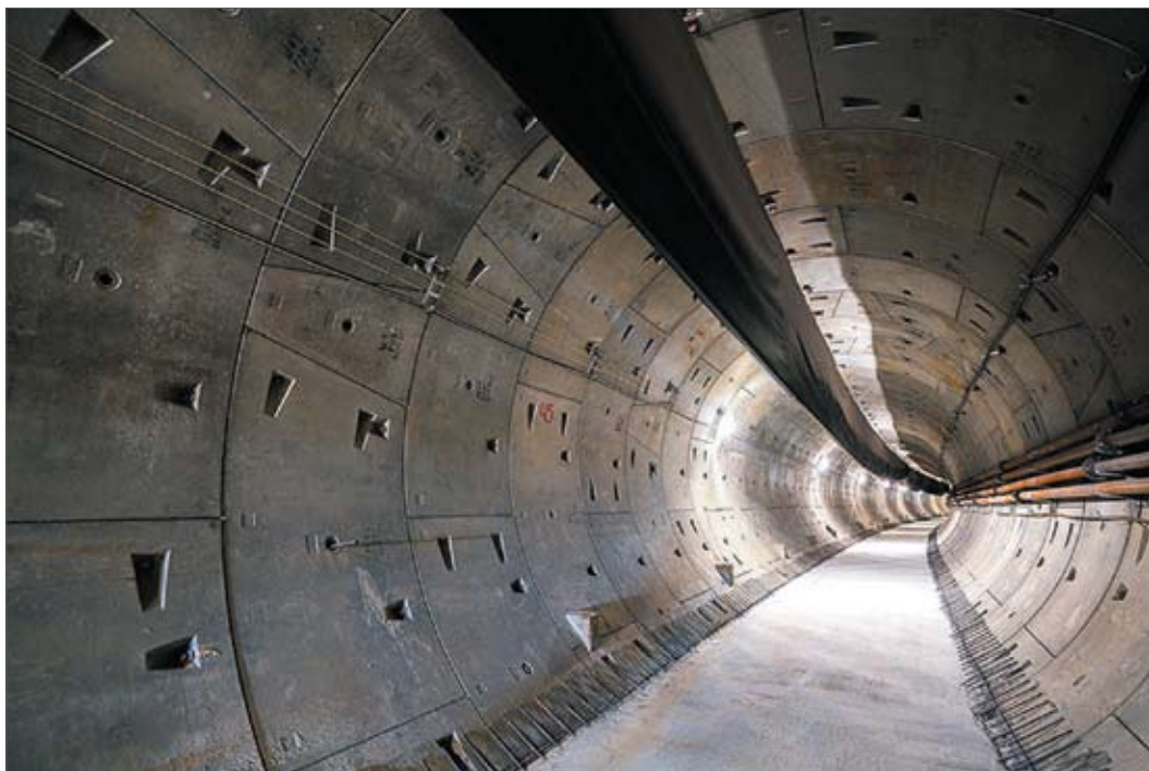
Новый тоннель третьей ветки Минского метрополитена
