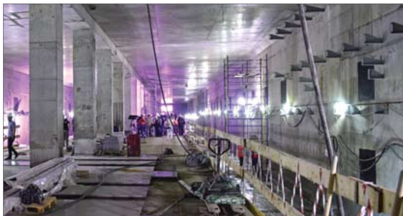
Строительство станции «Шереметьевская»
