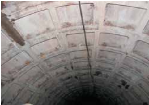
Рис. 2. Общий вид железобетонной тубинговой обделки ствола шахтной вентиляции
