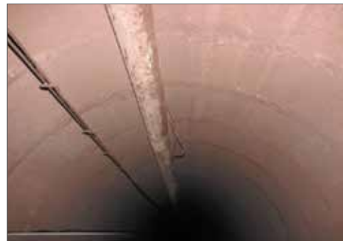
Рис. 3. Общий вид монолитной железобетонной обделки ствола шахтной вентиляции
