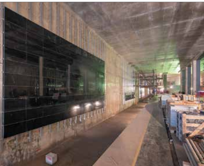
Отделка путевой стены на станции «Лефортово» БКЛ
