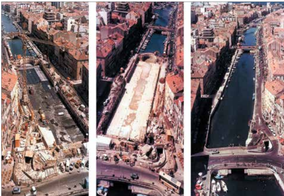
Устройство двухэтажного паркинга ниже дна реки в историческом городе Франции
