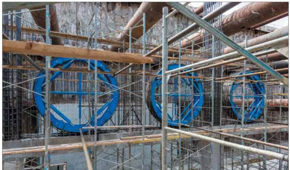
Монтаж опалубки круглых проемов на платформенной части под декоративное освещение на станции «Рубцовская» БКЛ
