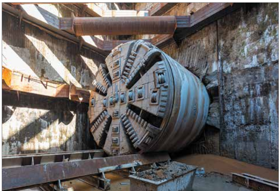
После успешной проходки правого перегонного тоннеля между станциями «Нижегородская» и «Авиамоторная» БКЛ щит выдвигают в демонтажную камеру для разборки
