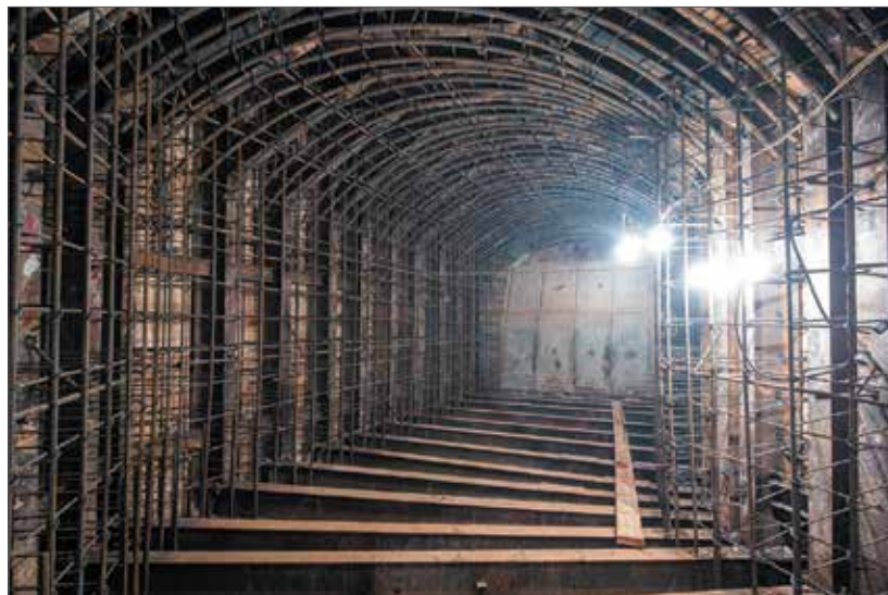
Сооружение пересадки между станциями «Ржевская» Большой кольцевой линии и «Рижская» Калужско-Рижской линии
