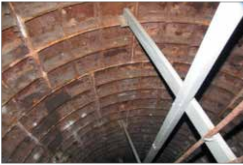
Рис. 1. Общий вид чугунной тубинговой обделки ствола шахтной вентиляции
