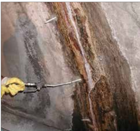
Рис. 8. Инъектирование смолы
