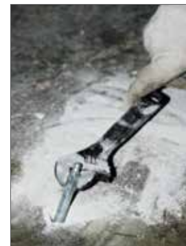
Рис. 6. Монтаж инъектора
