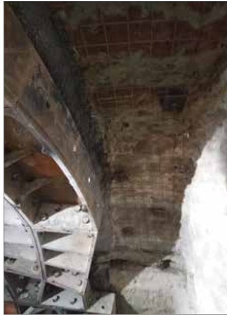
Предварительное крепление анкерами сводовой части и установка на них дорожной сетки
