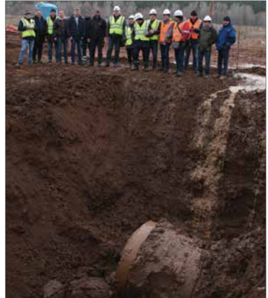
Рис. 6. Выход щита установки Direct Pipe®, Нижнекамск (Татарстан)
