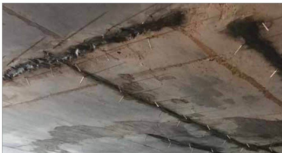
Рис. 7. Инъекторы, установленные на потолочной поверхности
