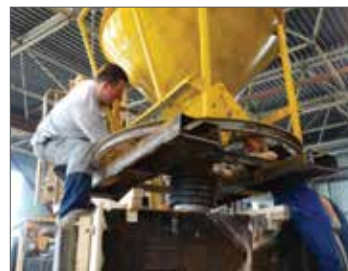
Рис. 9. Бетонирование обоймы
