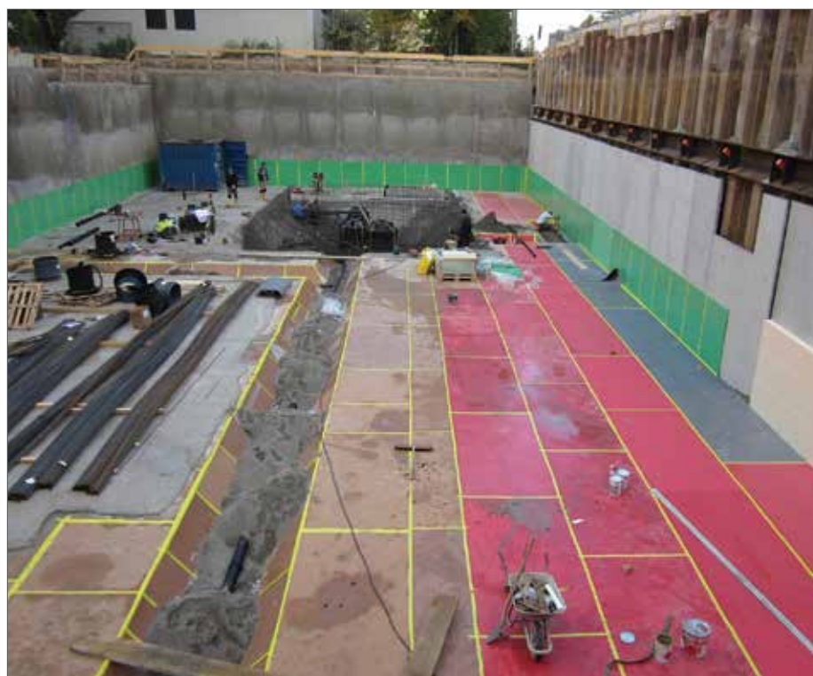
Рис. 1. Укладка виброизоляционных матов перед устройством фундамента
