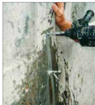
Рис. 5. Бурение отверстий
