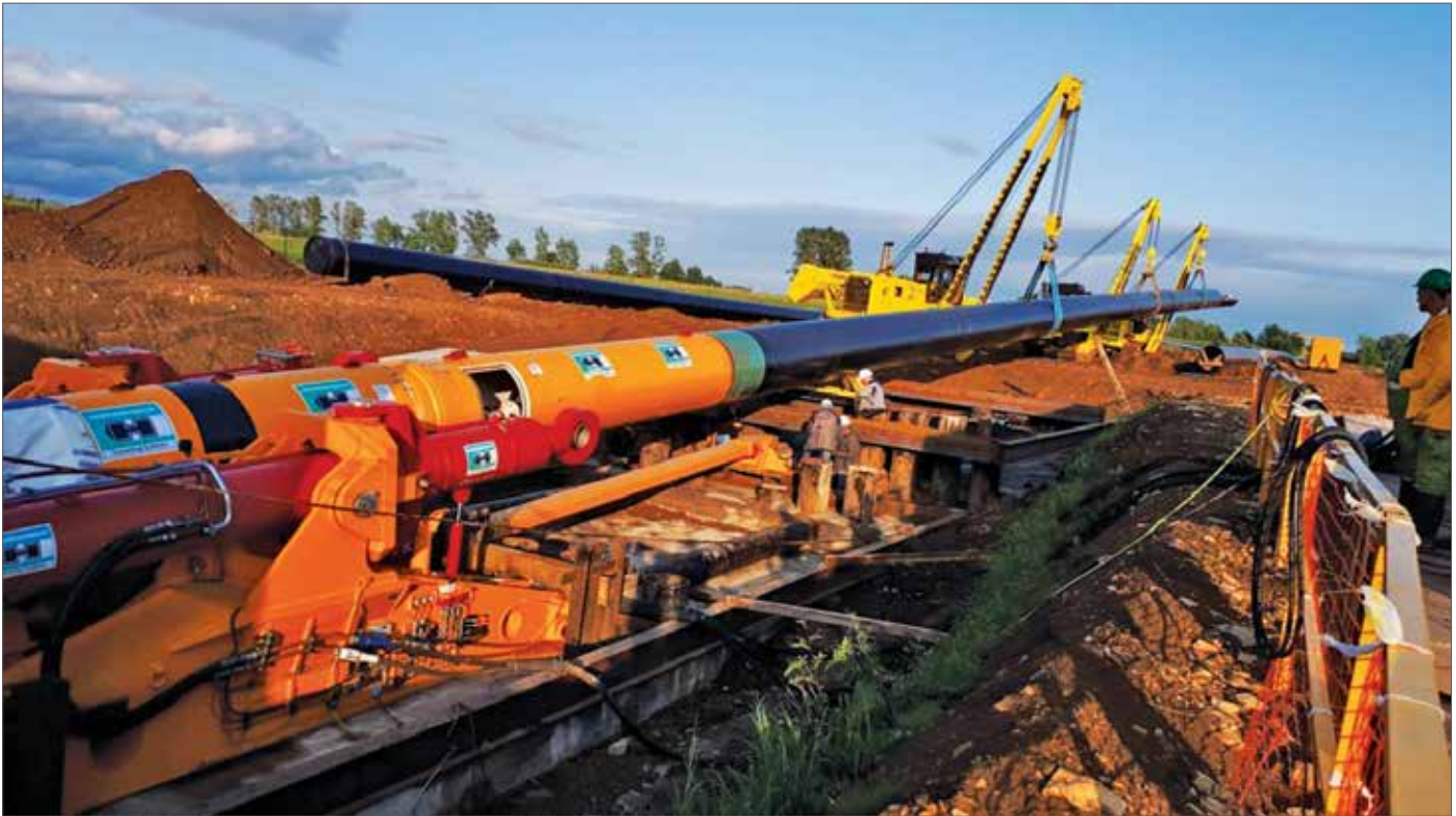
Рис. 4. Монтаж оборудования Direct Pipe® на стройплощадке в Нижнекамске (Татарстан)
