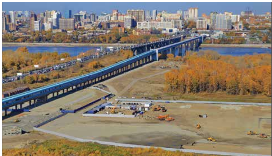
Подготовка площадки для строительства станции и ЛДС
