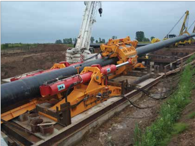
Рис. 5. Старт проходки методом Direct Pipe®, Нижнекамск (Татарстан)
