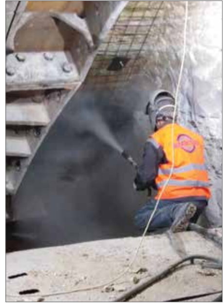
Производство работ по технологии «сухого» набрызг-бетонирования
