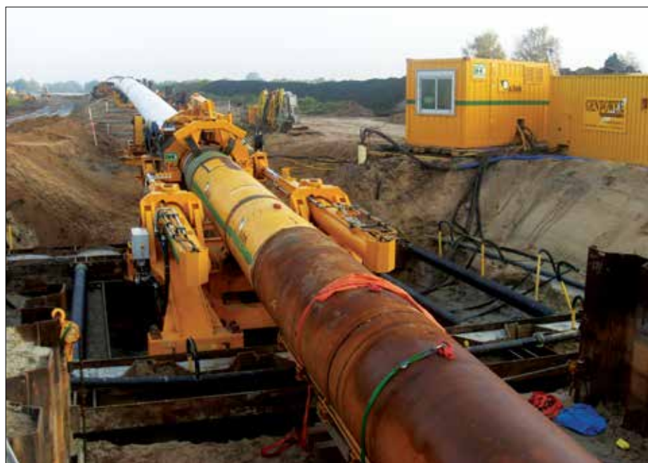
Рис. 3. Рабочая площадка Direct Pipe® в Нидерландах с доталкивателем труб, установленным в неглубоком стартовом приячке
