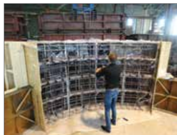
Рис. 8. Устройство гидроизоляции, установка каркаса и температурных датчиков
