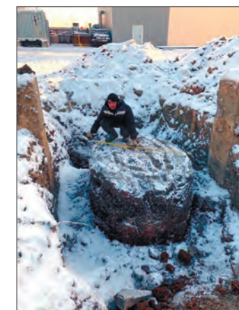
Рис. 2. Фото откопанного грунтоцементного элемента
