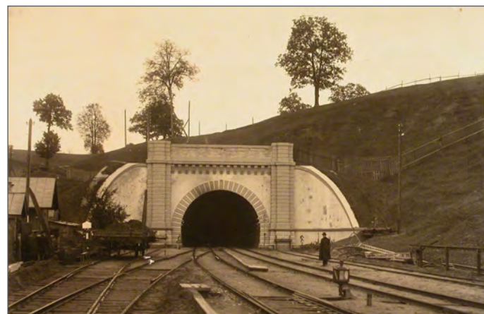
Рис. 1. Портал Ковенского тоннеля
