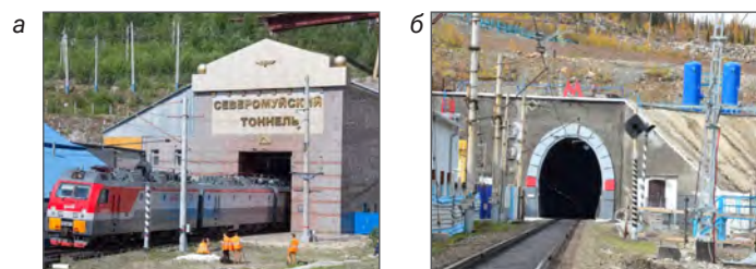
Рис. 3. Порталы Северо-Муйского (а) и второго Байкальского (б) тоннелей
