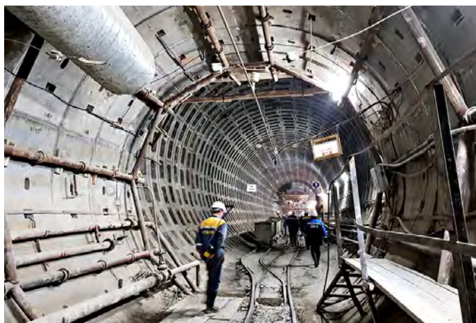
Строительство Лахтинско-Правобережной линии
