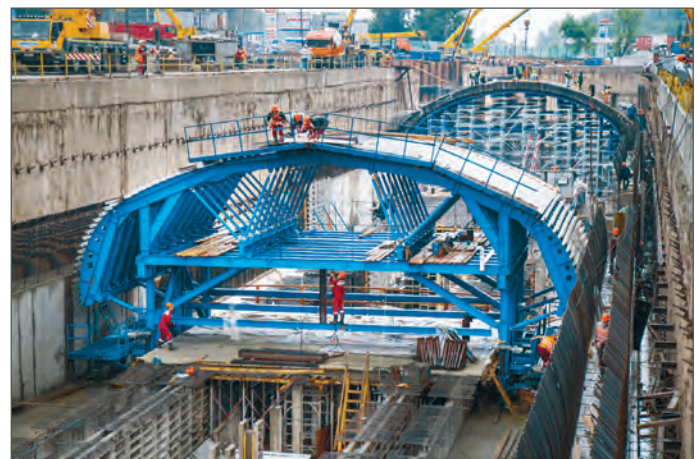
Рис. 2. Использование передвижной опалубки при строительстве станции метро «Тропарево» в Москве
