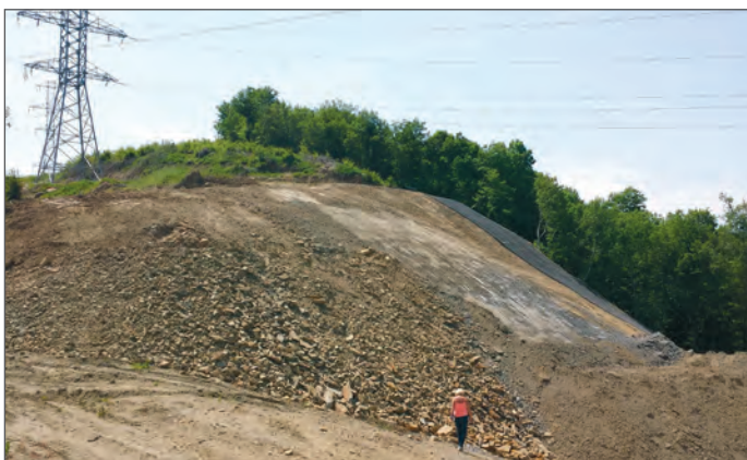
Откос в процессе выполнения мероприятий инженерной защиты
