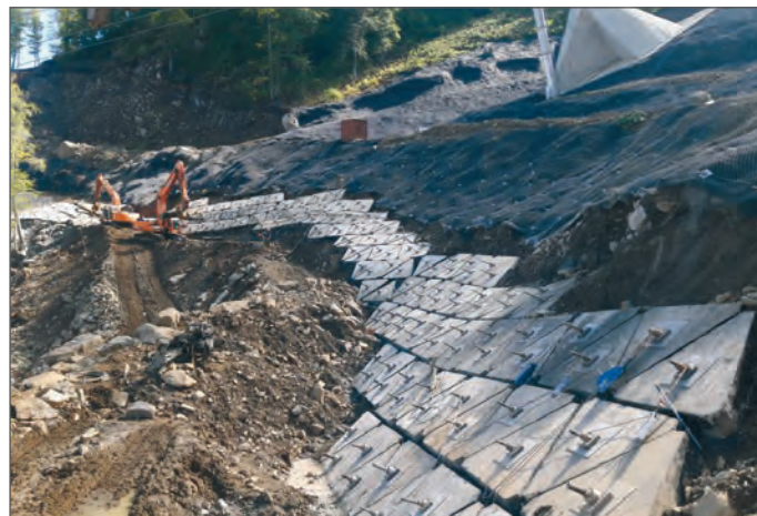
Анкерное крепление с прижимными плитами и нагельное поле выше по склону
