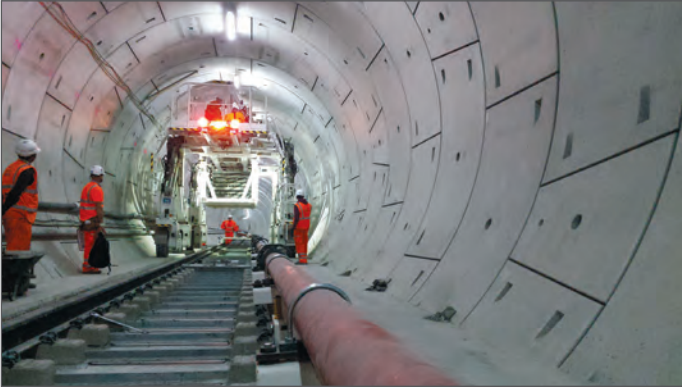
Рис. 1. Проверка стыков между блоками обделки
