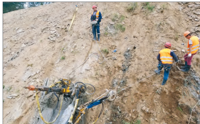
Выполнение нагельного крепления на склоне
