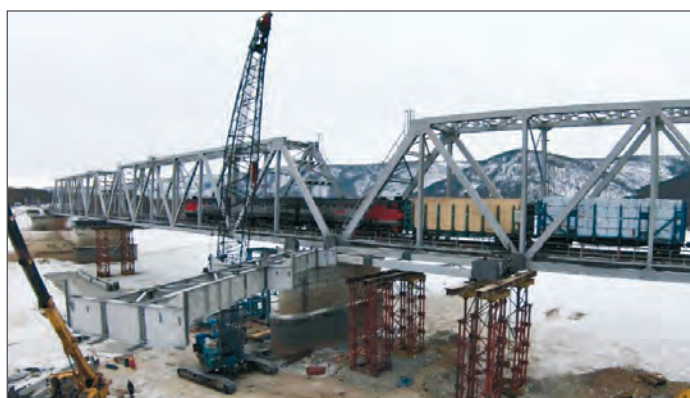
Строительство мостов под вторые пути на БАМе
