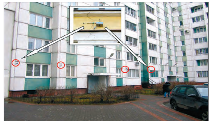
Рис. 5. Схема размещения датчиков инструментального мониторинга на одном из фасадов зданий
