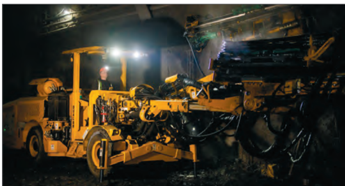
Строительство Керакского тоннеля
