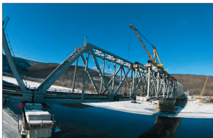
Строительство моста через реку Нюкжа
