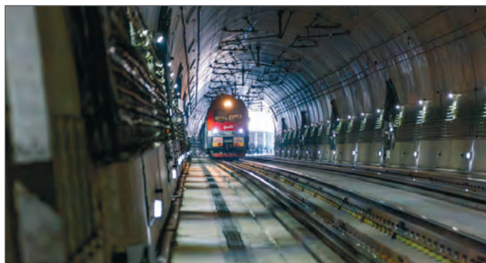
Открытие движения в Керакском тоннеле
