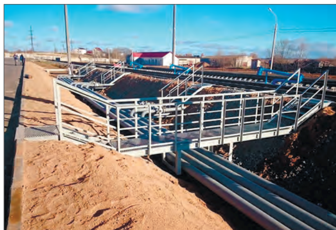
Рис. 1. Временный металлический мост через котлован
