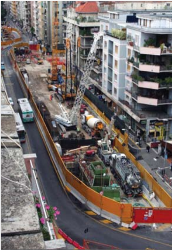
Рис. 2. Строительство ведется в стесненных условиях
