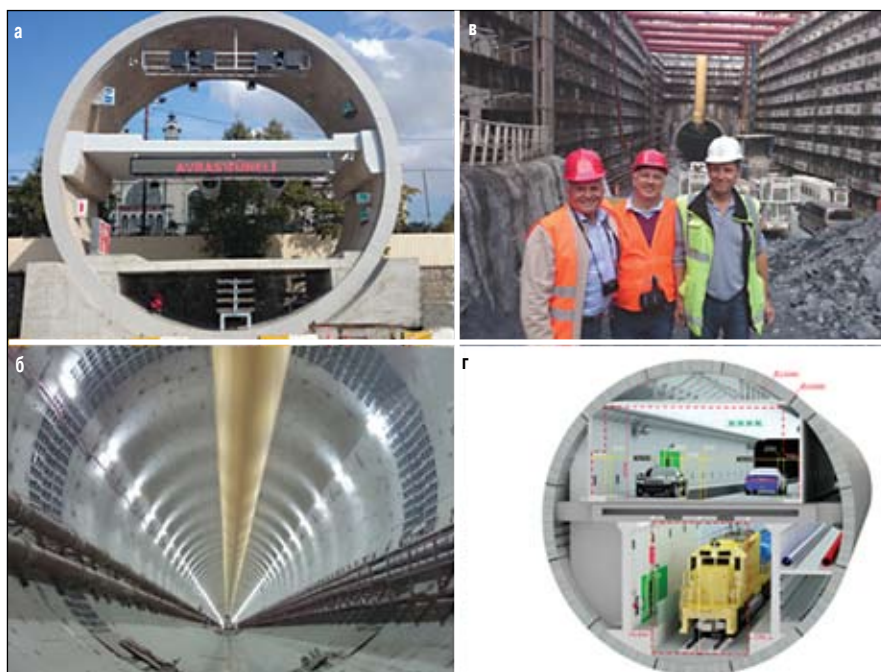
Рис. 8. а, б — автодорожный тоннель под проливом Босфор в Турции; в — визит на объект, г — авторский вариант аналогичного тоннеля под Керченским проливом
