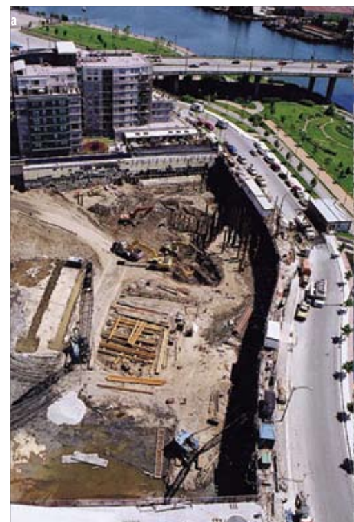
Рис. 4. Цементационные работы для восстановления разрушенного
