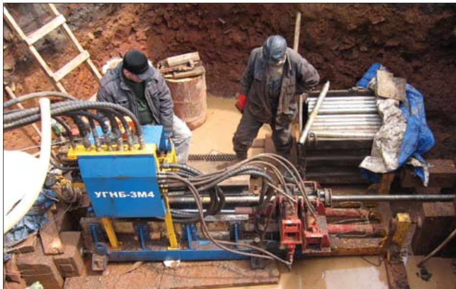
УГНБ-3М4. Установка котлованного типа УГНБ-3М4 на о. Кунашир Курильские острова работает третий год в компании ООО «Южно-курильский водоканал», в тяжелых скальных грунтах проложено более 15 км коммуникаций
