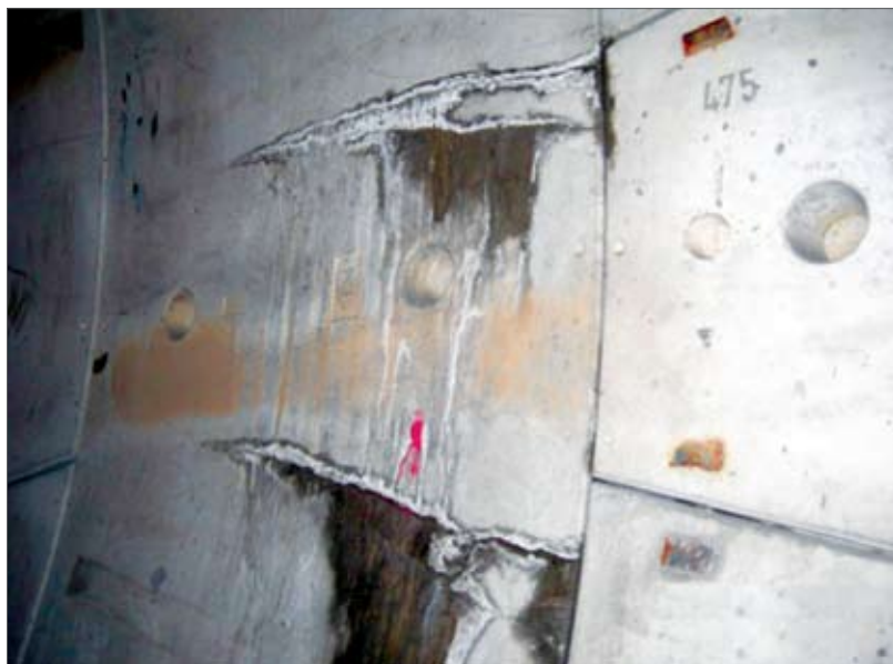
Quadro fessurativo nei conci prefabbricati in gallerie scavate con TBM
