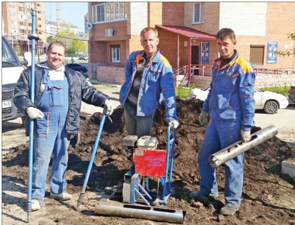
УГБ-2М. Компания ООО «СервисЭлектроСнаб» в городе Тольятти за период в три года проложила более 4 тыс. метров коммуникаций на установке УГБ-2М
