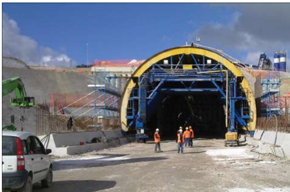
Шоссе А14, тоннель Саппанико, Италия
