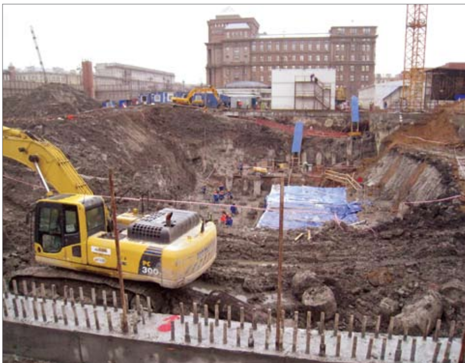
Котлован для строительства двухэтажной подземной парковки под здание «МКК» возле станции метро «Электросила»
