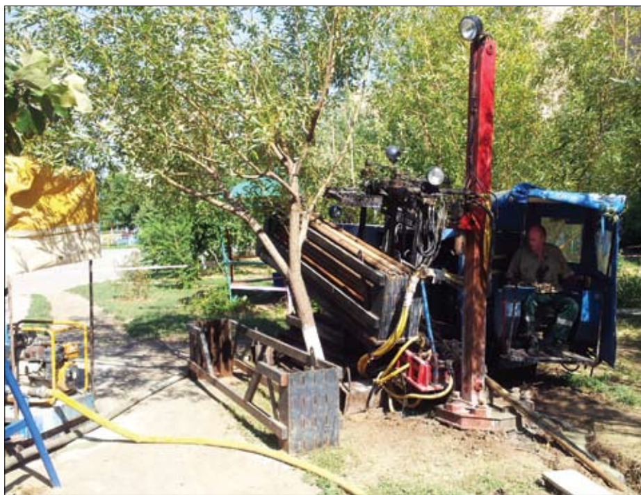
УГНБ-4. Самоходная установка УГНБ-4 отработала по Ростовской области более 5 лет, проложено более 40 км коммуникаций
