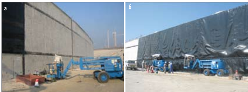
Рис. 7. Гидроизоляция автодорожного тоннеля на Пальмовом острове в Дубае
