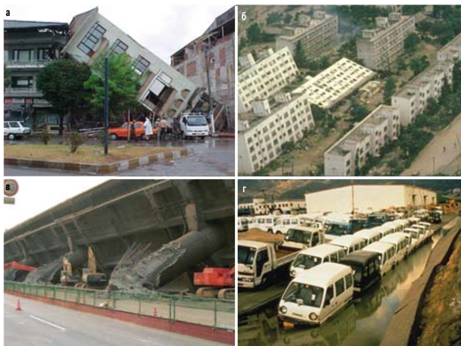
Рис. 1. Обрушения, обусловленные качеством строительства фундаментов и оснований
