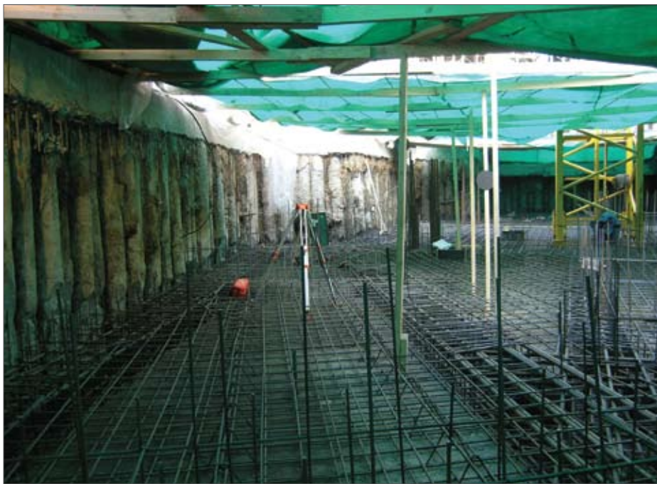
Котлован для строительства подземного этажа офисного здания «Регент холл»
