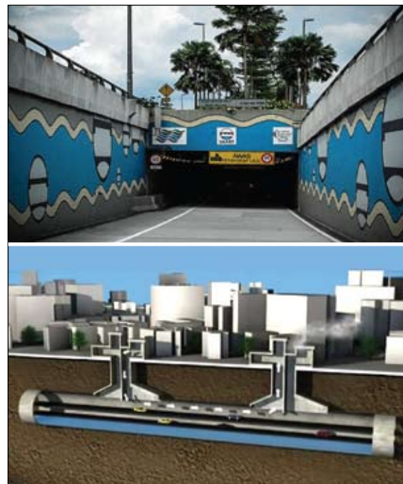
Рис. 6. Тоннель Smart в Куала-Лумпуре, Малайзия
