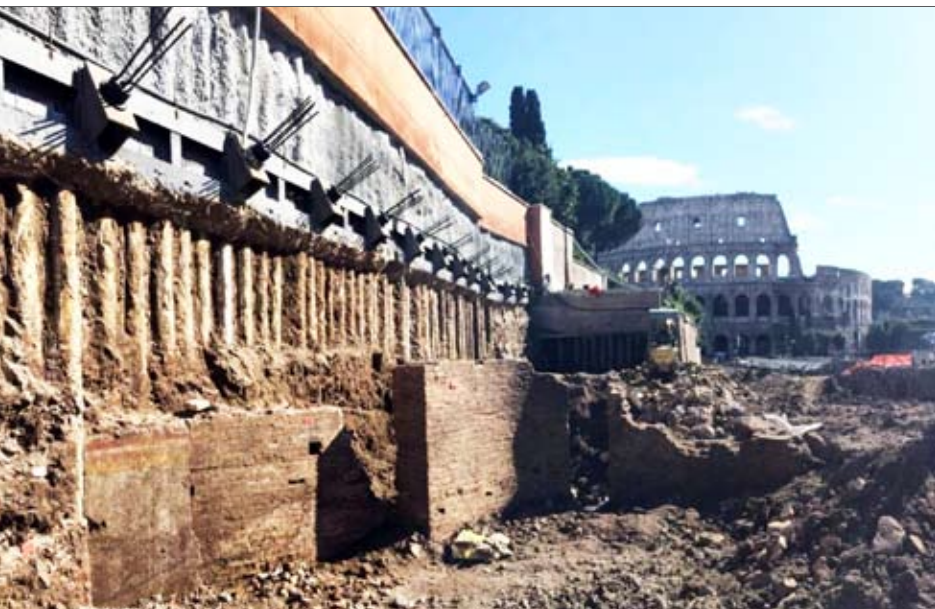
Рис. 11. Строительство станции «Императорский форум»
