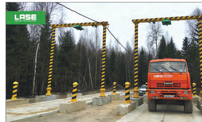
Рис. 1. Лазерные 3D-сканеры в парной комбинации на КПП объекта
