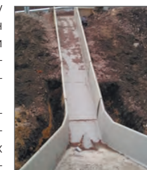
Рис. 3. Водоотвод из композитных лотков
