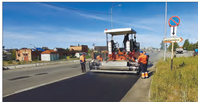
Гусеничный асфальтоукладчик АСФ-Г-4-04 в работе
