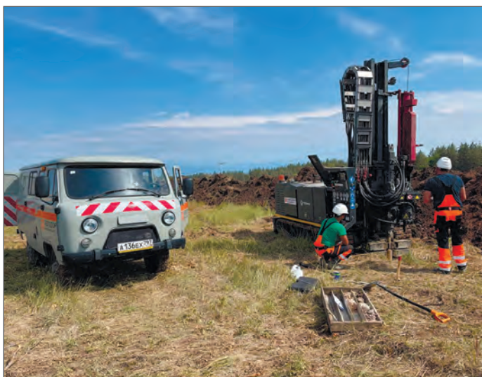
Рис. 5. Выполнение работ по контрольному бурению с применением буровой установки УГБ-996 «Пионер». М-12, VIII этап, Республика Татарстан, 2021 год. Из фототеки ООО «Автодор-Инжиниринг»
