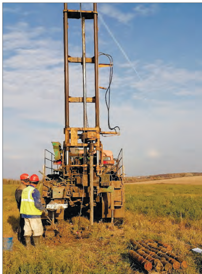
Рис. 4. Фотофиксация процесса буровых работ. М-12, V этап, Нижегородская область, 2020 год. Из фототеки ООО «Автодор-Инжиниринг»
