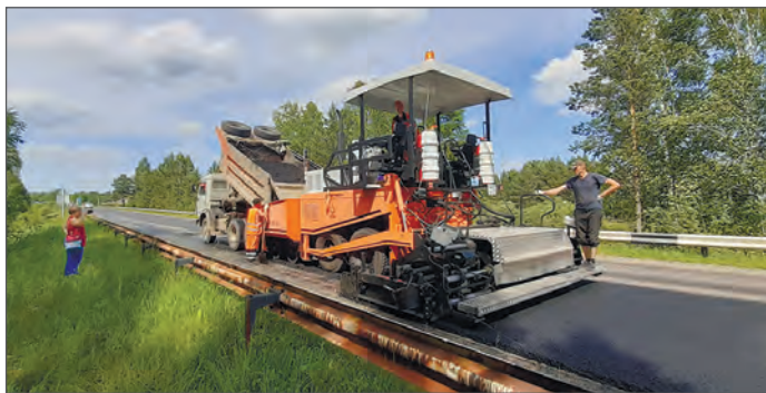
Колесный асфальтоукладчик АСФ-К-4-02-2 в работе
