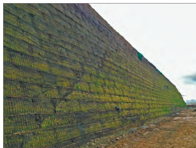
Рис. 1. «Зеленая стена» из арматурных конструкций («Тенсар»)
