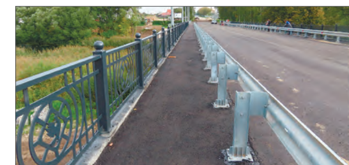
Устройство дорожной одежды, барьерного ограждения, освещения, эксклюзивных перильных ограждений
