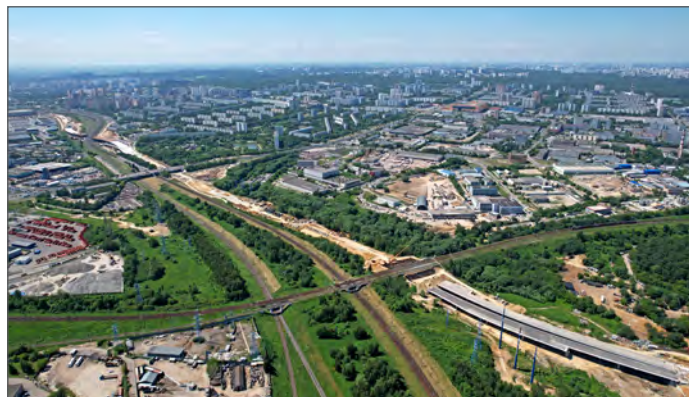
Строительство путепровода тоннельного типа на участке МСД
