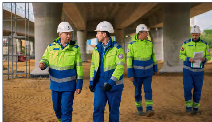
Константин Маслаков с командой «МИПСТРОЙ 1» на строительной площадке МСД
