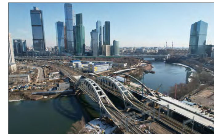
Строительство Северного дублера Кутузовского проспекта. Фото: Пресс-служба Комплекса градостроительной политики и строительства Москвы
