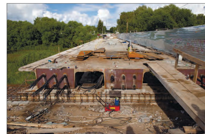
Рис. 5. Натяжение канатов Ø 15,7 мм
