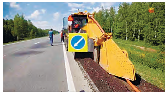
Рис. 1. Укладка ЛКС в обочинах
