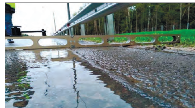
Рис. 2. Возвышение покрытия литого асфальтобетона в месте прокладки ЛКС способствует застою воды над ЛКС ТМК и препятствует обеспечению поверхностного стока в поперечном направлении
