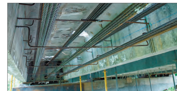
Канаты преднапряжены, бх 2 прядей Ø 15,7 мм
