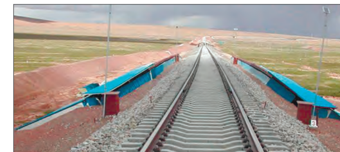
Рис. 2. Солнцезащитные навесы на откосах насыпи Цинхай-Тибетской железной дороге, август 2006 года
