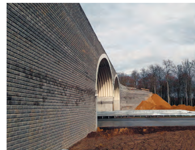
Рис. 3. Внешний вид армогрунтовой конструкции с системой «Инорблок»
