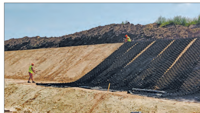
Укрепление откосов выемок автодороги «Европа – Западный Китай»
