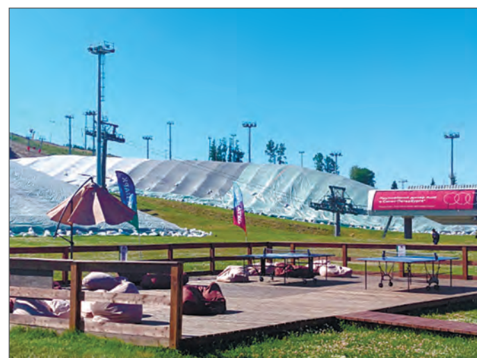
Рис. 4. Бурты снега на лыжной трассе, укрытые материалом «Тепофол» (Охта-парк в Ленинградской области, июль 2022 года)
