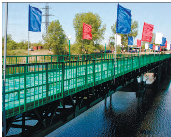
Рис. 3. Средний автомобильный разборный мост
