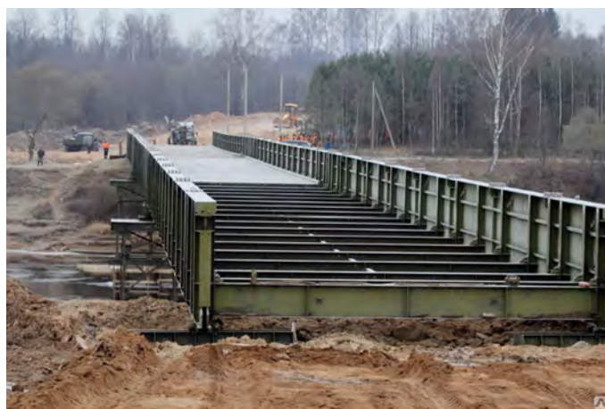
Рис. 6. Большой автодорожный разборный мост
