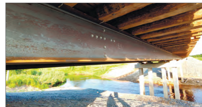
Рис. 9. Мост через р. Пуксу в Пинежском районе Архангельской области на региональной автомобильной дороге с пролетами из стали 14ХГНДЦ
