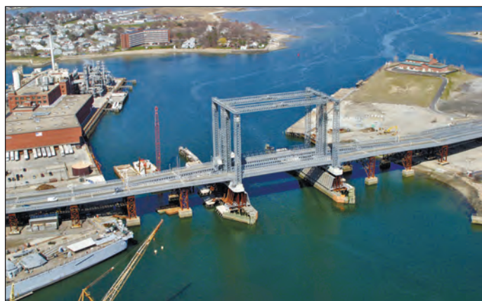
Рис 6. Два моста Ascrow 700XS с подъемным пролетом 64 м [5]
