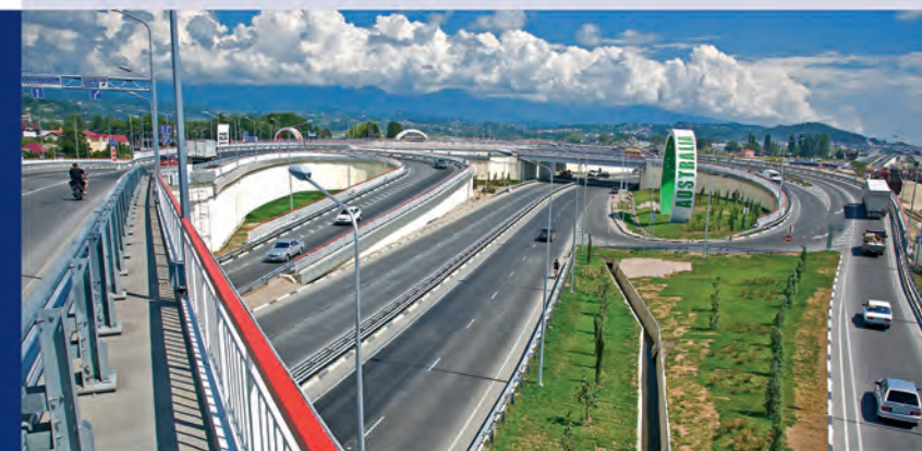
Транспортная развязка «Адлерское кольцо», г. Сочи Железобетонные конструкции: ФЕРРОТАН-про + ПОЛИТОН-УР + ПОЛИТОН-УР(УФ)
