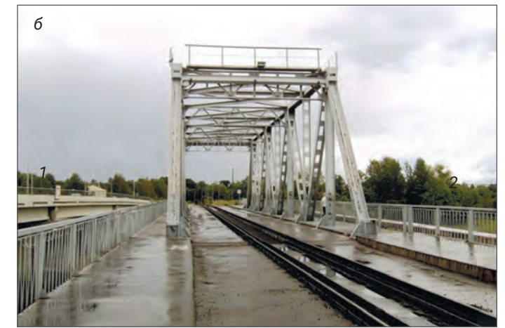
Рис. 6. Вид совмещенного автомобильно-железнодорожного моста: а — до переустройства; б — после переустройства; 1 — однопутный железнодорожный мост; 2 — автодорожный мост
