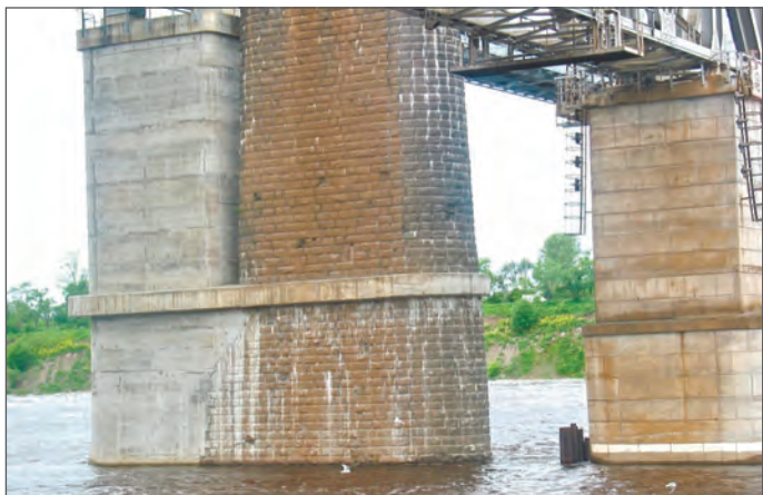
Рис. 4. Общий вид русловой опоры после ее уширения (железнодорожный мост через р. Волхов у ст. Волховстрой)
