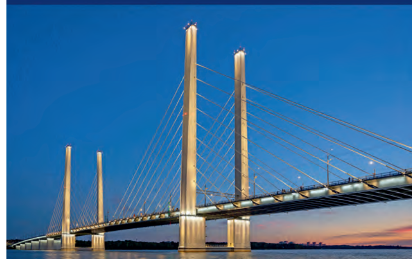
Мостовой переход «Архангельский» через р.Шексна, г.Череповец Металлические конструкции: ЦИНОТАН + ПОЛИТОН-УР + ПОЛИТОН-УР (УФ) Железобетонные опоры и пилоны: ФЕРРОТАН-про + ФЕРРОТАН + ПОЛИТОН-УР (УФ)
