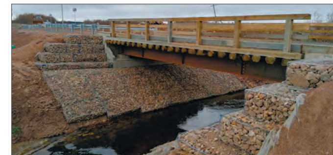
Рис. 8. Мост в Пинежском районе Архангельской области через р. Юбру на региональной автомобильной дороге Пиринемь — Труфаново с пролетами из стали 14ХГНДЦ
