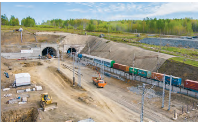
Строительство Керакского тоннеля
