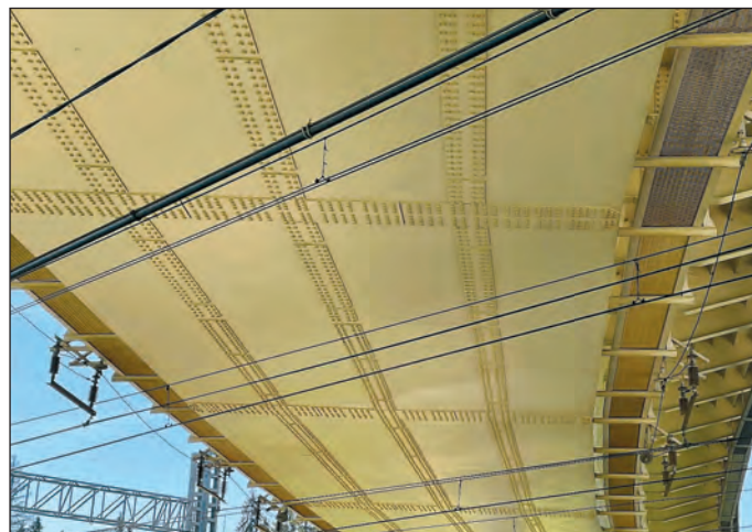
Рис. 4. Нижний пояс коробчатого пролетного строения, сварные монтажные стыки которого усилены высокопрочными болтами
