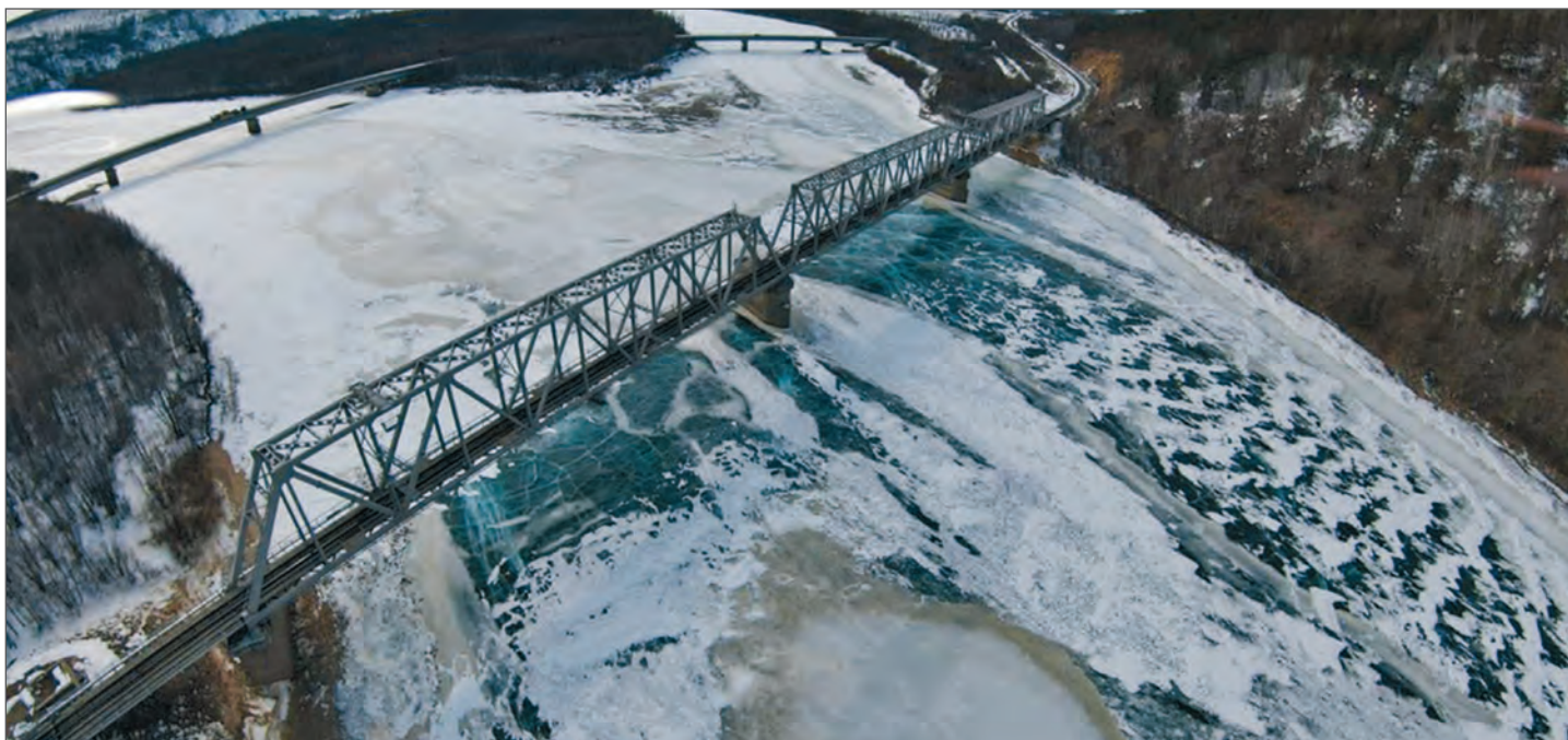
Мост через реку Нюкжу, «Мосты на БАМе»
