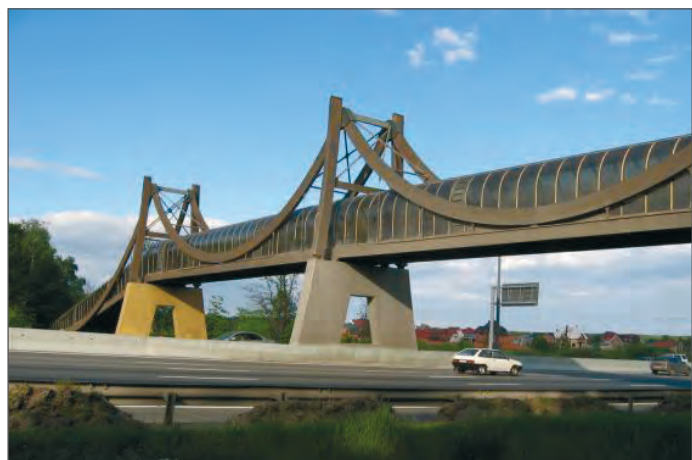
Рис. 4. Пешеходный мост «102 км МКАД»
