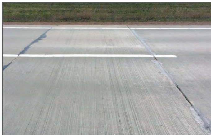
Шов расширения в ц/б покрытии спустя 12 лет
