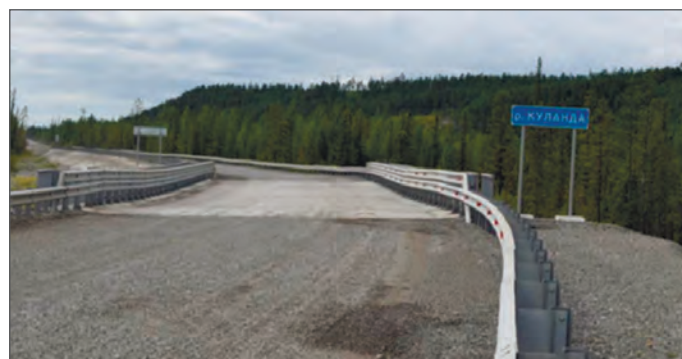
Рис. 2. Проезжая часть из цементобетона на мосту автодороги «Колыма»
