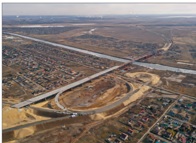
Волгоградская область, мост через Волго-Донской канал, обход Волгограда
