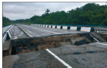
Рис. 1. Разрушение мостов
