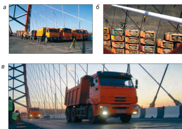
Рис. 3. Расположение нагрузки на мосту при проведении испытаний: а — вид справа (при статических испытаниях); б — вид сверху; в — динамический проезд нагрузки
