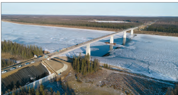
Республика Саха (Якутия), мост через реку Марху в составе трассы А-331 «Виллюй»
