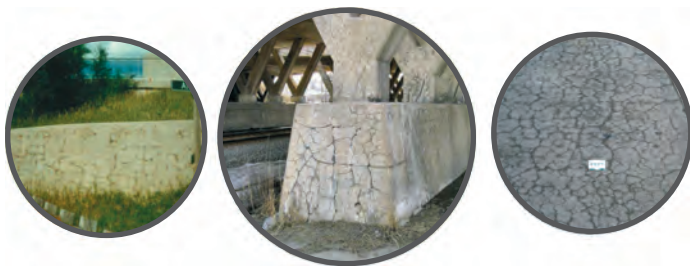
«Карточная» система трещин — один из характерных признаков щелочной-силикатной реакции
