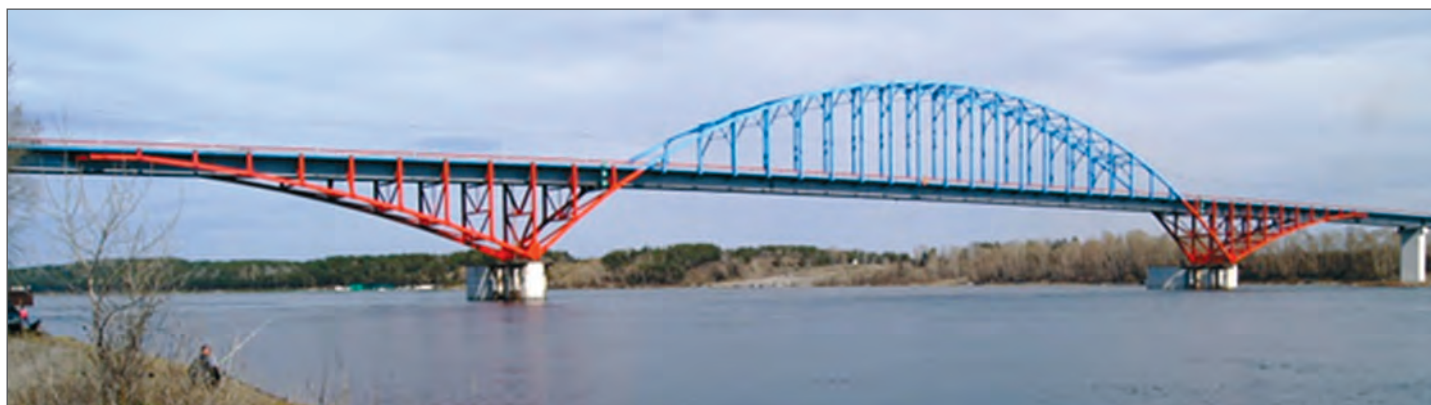
Рис. 5. Общий вид руслового пролетного строения (правый фасад)
