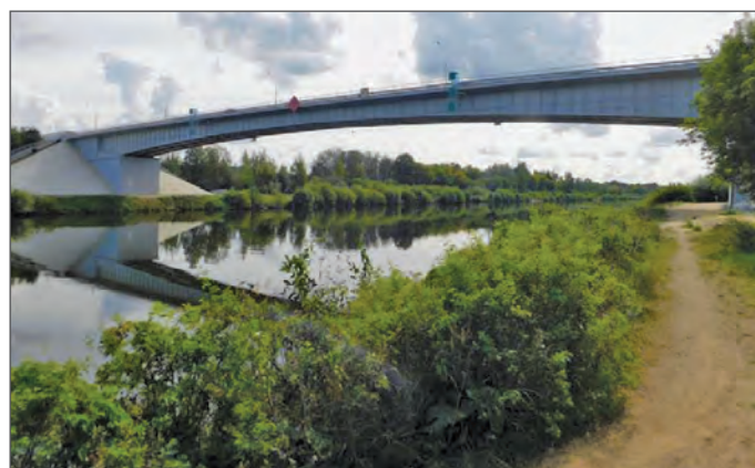
Мост через канал им. Москвы на км 25+533 автомобильной дороги А-107 Металлический мост Год постройки 1953 1982 год – ремонт 1986 год – ремонт 1999 год – реконструкция 2004, 2005 годы – ремонт 2023 год – капитальный ремонт
