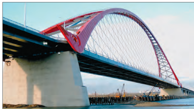
Рис. 1. Пролетное строение 5-6 (правый фасад)
