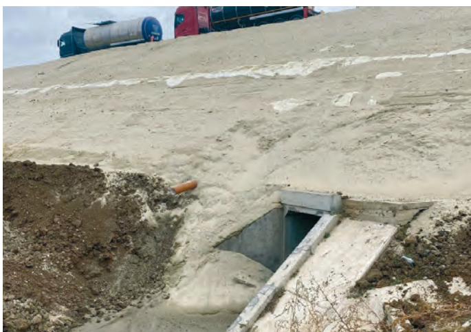
Рис. 7. Процесс восстановления откоса на дороге Р-228
