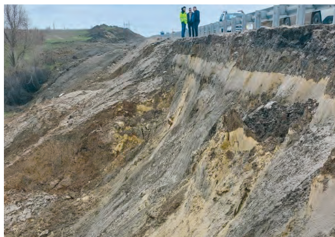
Рис. 5. Сползание откоса на дороге Р-228 Сызрань – Саратов
