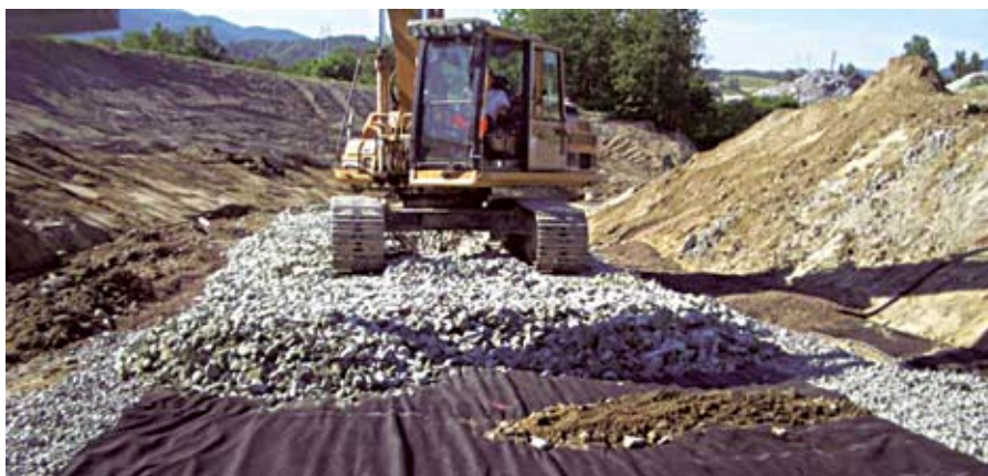
Рис. 1. Устройство морозозащитного слоя из гранулированного пеностекла производства Nasorog на опытно-экспериментальном участке автодороги E6 Melhus (фотография из технических отчетов Норвежского управления дорогами общего пользования)
