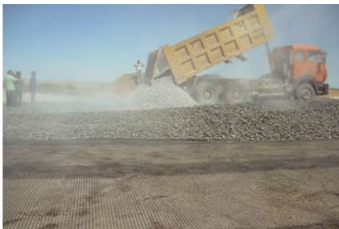
Рис. 5. Отсыпка щебня автосамосвалами
