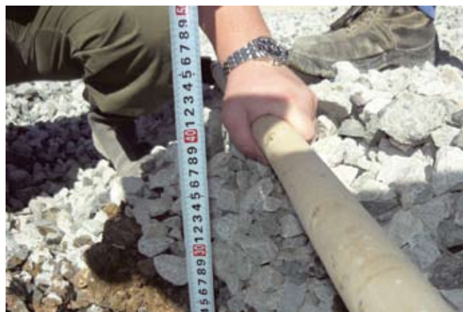
Рис. 10. Устройство шурфа в месте проведения штампового испытания
