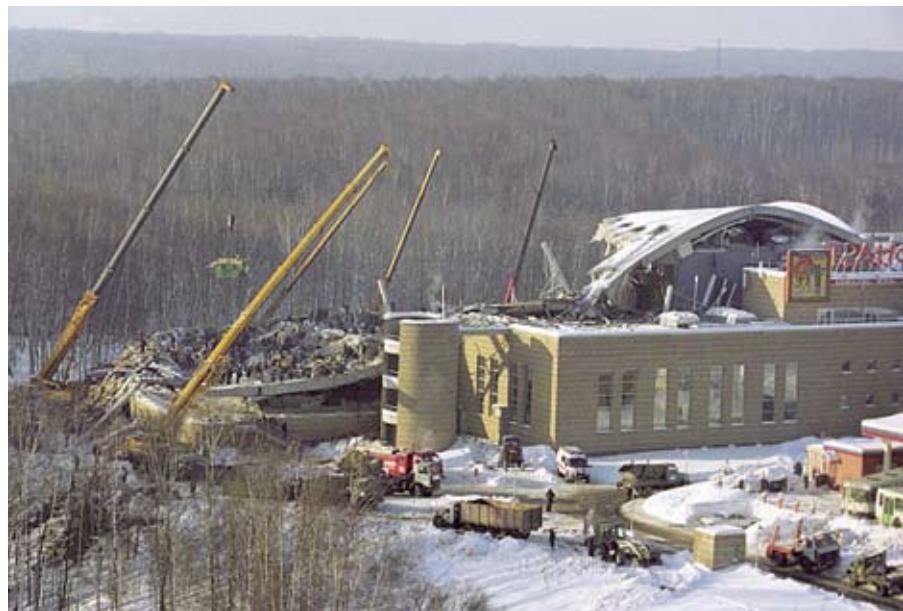
Обрушение развлекательного комплекса «Трансвааль-парк»
