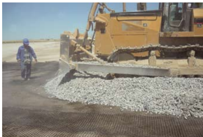
Рис. 6. Выравнивание слоя щебня бульдозером
