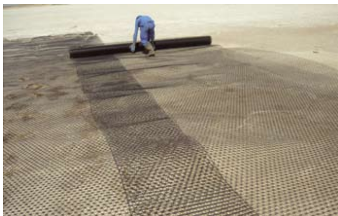
Рис. 3. Укладка полотен георешетки на слабое основание
