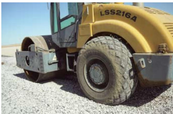
Рис. 7. Уплотнение слоя щебня катком
