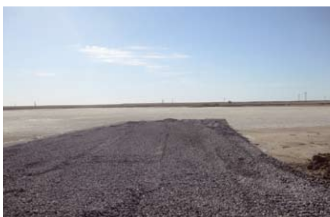
Рис. 8. Слой щебня после уплотнения со следами от вальцов катка
