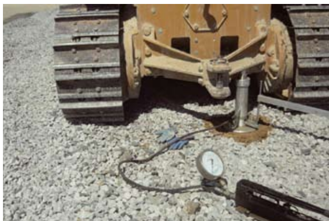
Рис. 9. Проведение штампового испытания
