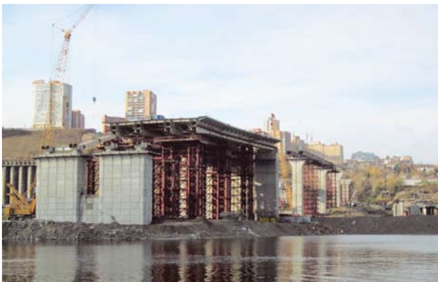
Монтаж пролетных строений 8-10 с земли
