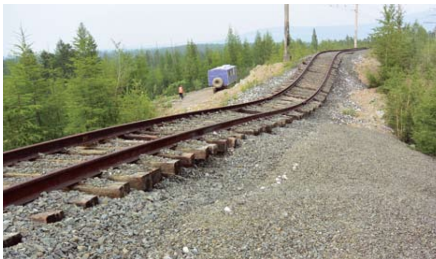
Рис. 4. Деформации пути вследствие деградации многолетней мерзлоты в его основании, подъездной путь Чара — Чина (июль 2015 г.)
