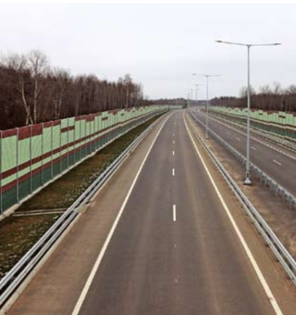
Скоростная автомобильная дорога Москва — Санкт-Петербург
