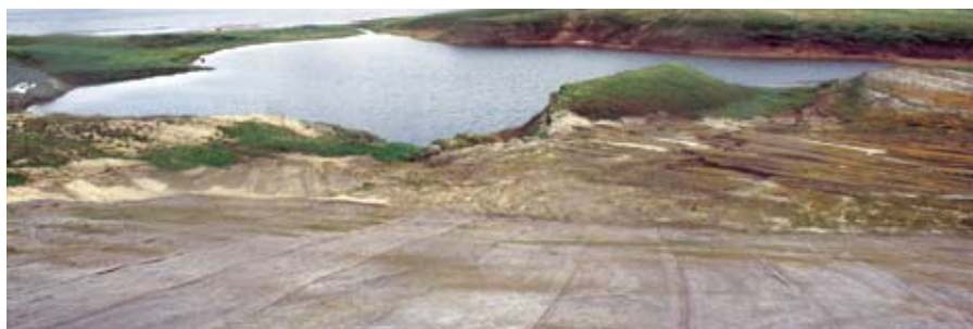
Рис. 2. Откосы насыпи на км 543, укрепленные биоматами
