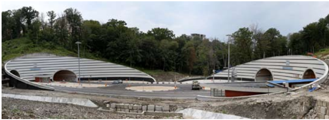
Тоннели на Дублере Курортного проспекта (Сочи)
