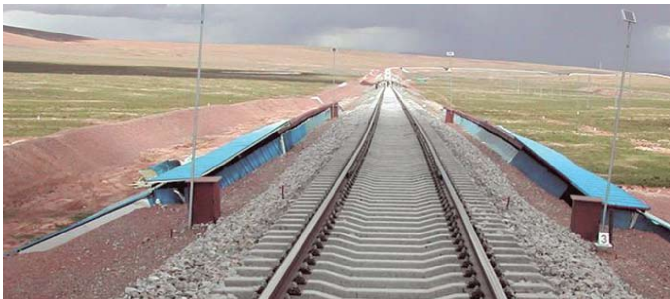
Рис. 7. Солнцеосадкозащитные навесы на откосах насыпи Цинхай-Тибетской железной дороги (август 2006 г.)
