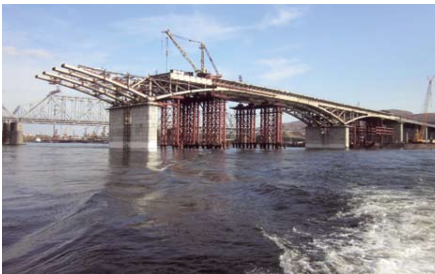
Монтаж пролетного строения краном МДК63
