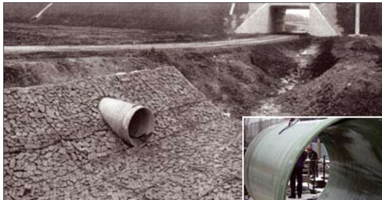
Водопрпускные трубы из композитных материалов на автомобильной дороге М-4 «Дон»
