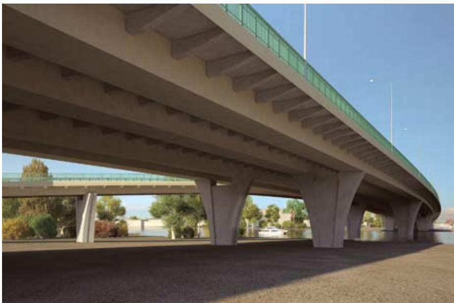
Строительство эстакады «Восточная»
