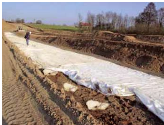
Рис. 3. Выполнение работ на опытном участке
