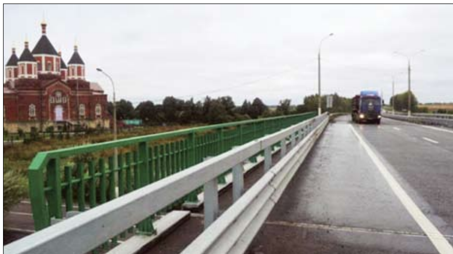
Перила из композиционного материала на автомобильной дороге М-3 «Украина»
