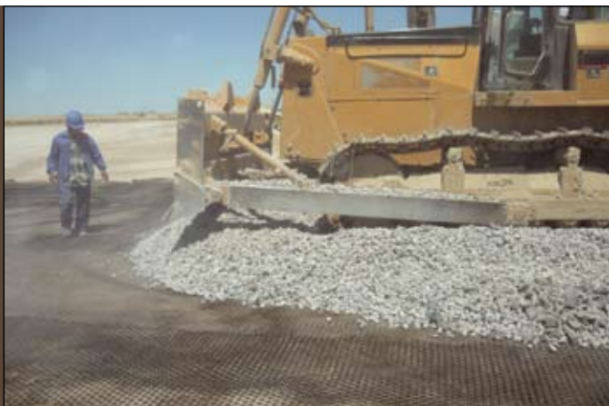
Рис. 6. Выравнивание слоя щебня бульдозером
