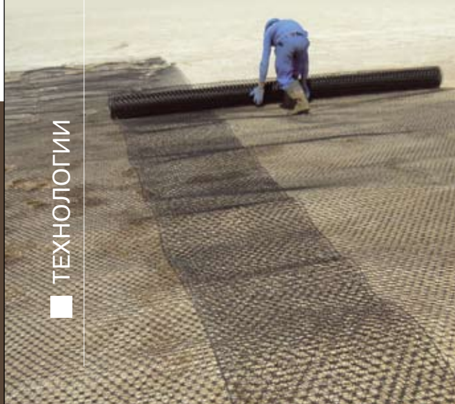
Рис. 3. Укладка полотен георешетки на слабое основание
