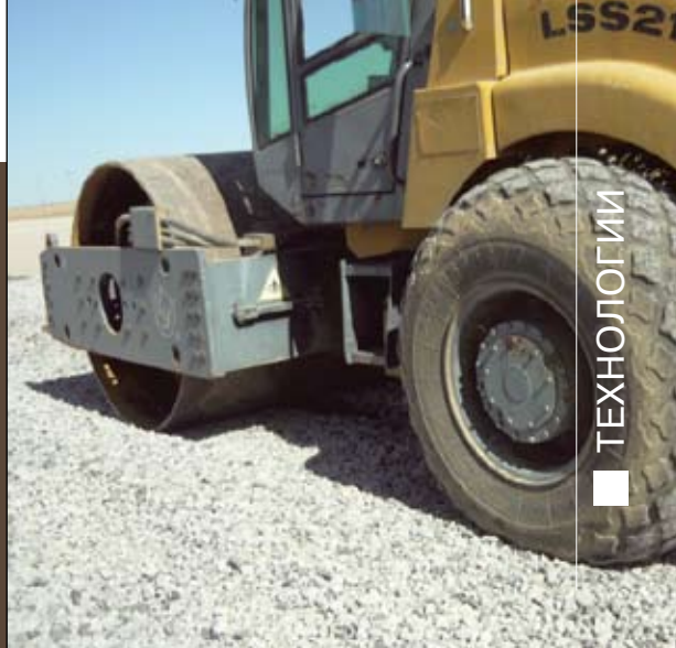
Рис. 7. Уплотнение слоя щебня катком
