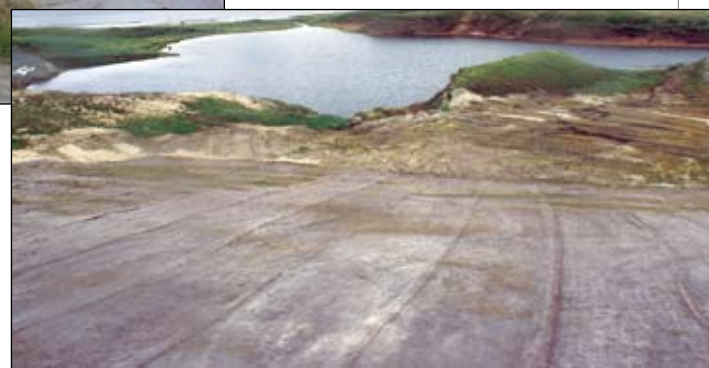
Рис. 1. Эрозия откосов выемки на км 536 через 2 года после окончания работ
