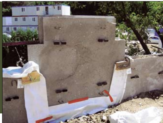
Крестообразная панель с анкерным креплением Геомега
