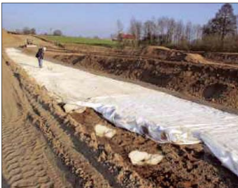
Рис. 3. Выполнение работ на опытном участке
