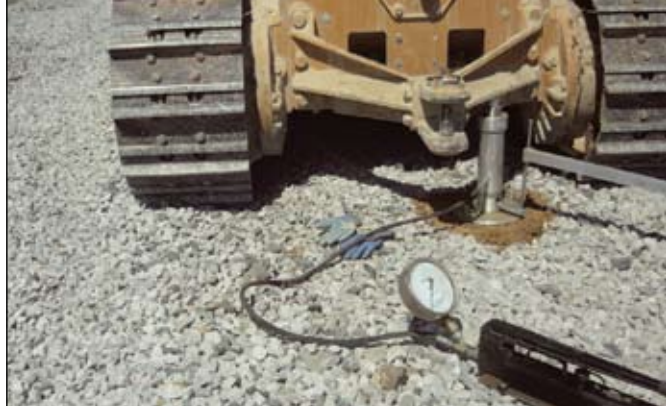
Рис. 9. Проведение штампового испытания
