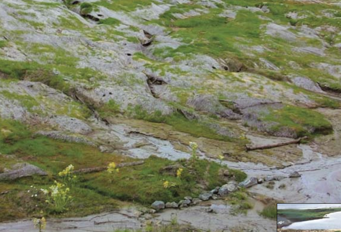
Рис. 1. Эрозия откосов выемки на км 536 через 2 года после окончания работ
