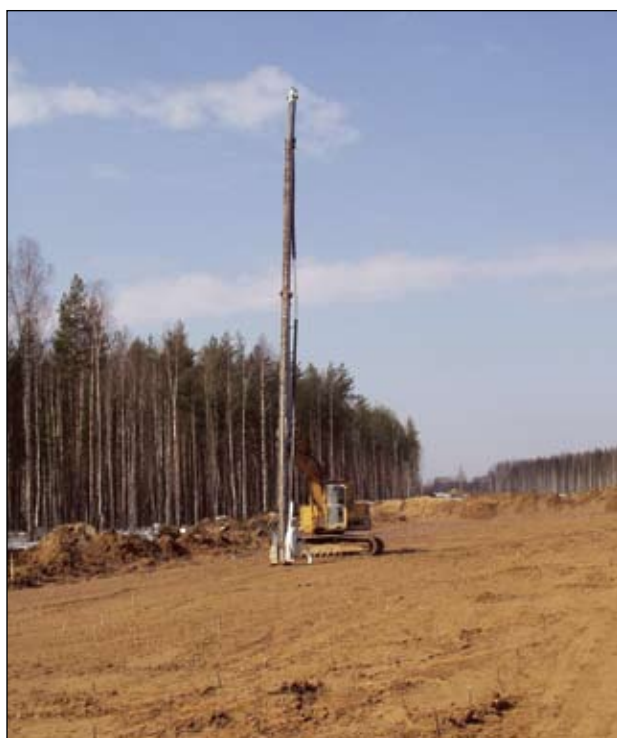
Рис. 2. Оборудование для погружения геодрен, используемое на Санкт-Петербургской КАД
