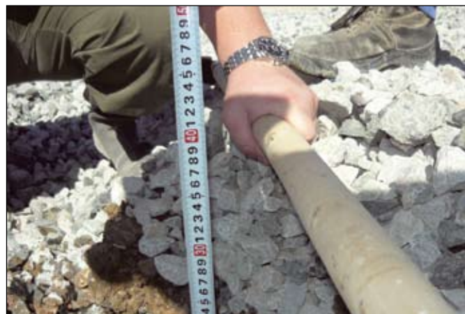
Рис. 10. Устройство шурфа в месте проведения штампового испытания
