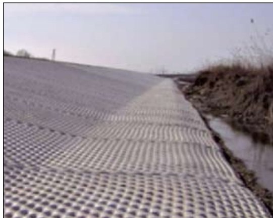
Рис. 8. Бетонаполняемые маты Incomat®
