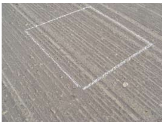
Рис. 1. Поверхность нижнего слоя отфрезерованного дорожного покрытия, размеченная для взятия вырубki-
