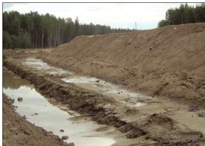
Рис. 4. Процесс отжима воды из слабого грунта основания насыпи
