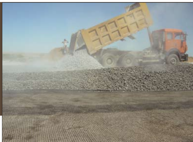
Рис. 5. Отсыпка щебня автосамосвалами
