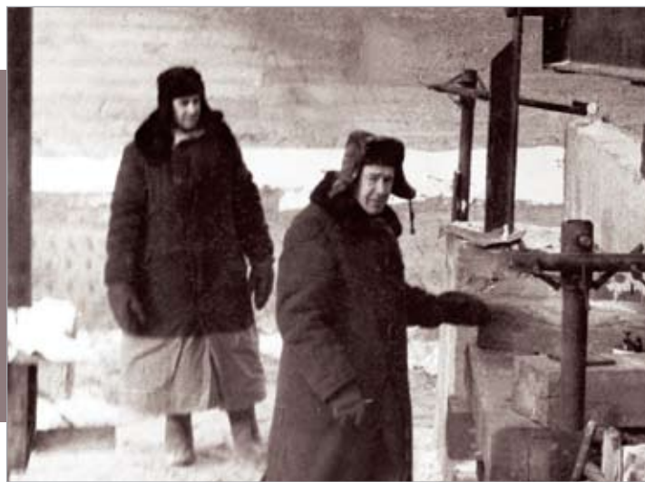
Испытание балок при температуре -50^{\circ}\text{C} , Тува 1963 г.
