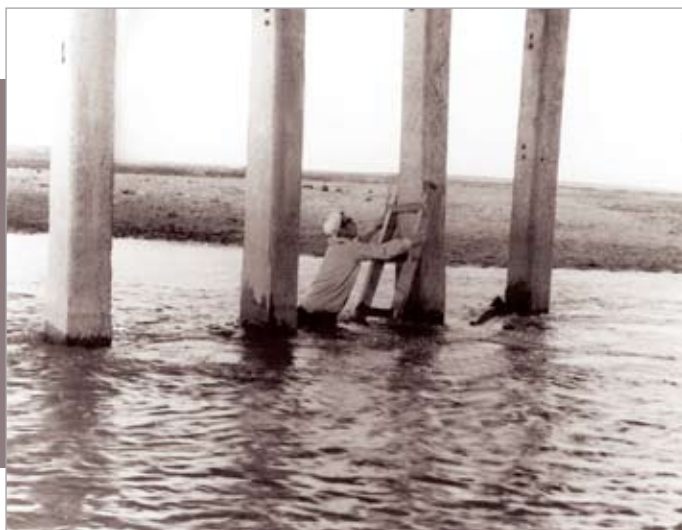
Обследование опор, Монголия, 1964 г.
