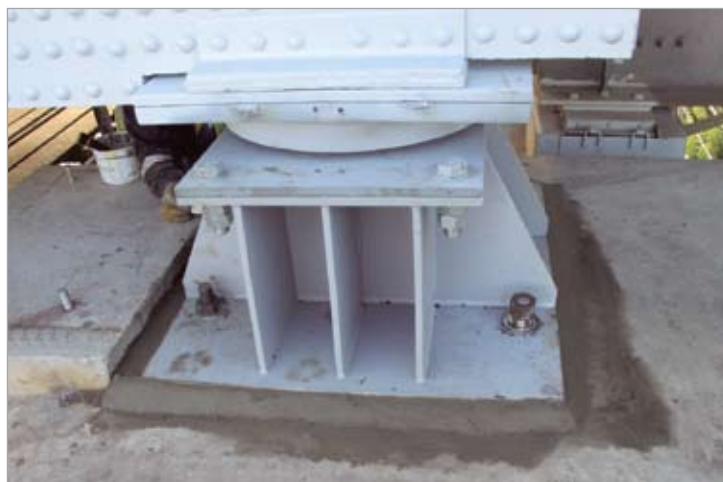
Шаровая сегментная опорная часть с переходной тумбой
