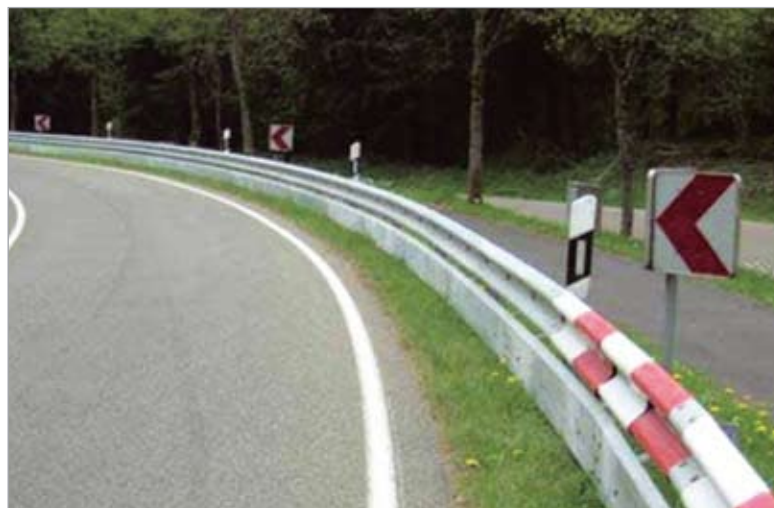
Рис. 4. Совмещение дорожного ограждения и противоподкатного бруса
