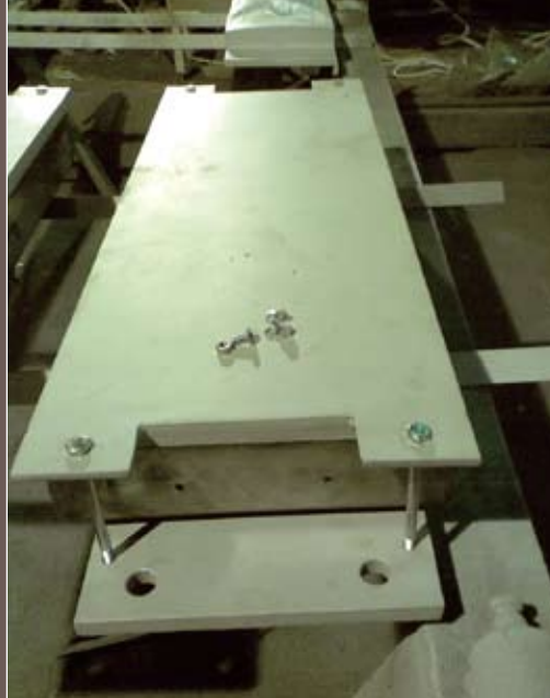
Тангенциальные скользящие опорные части для здания в Щелково
