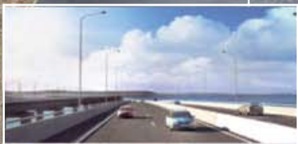
Мост огибает крепость Керчь
