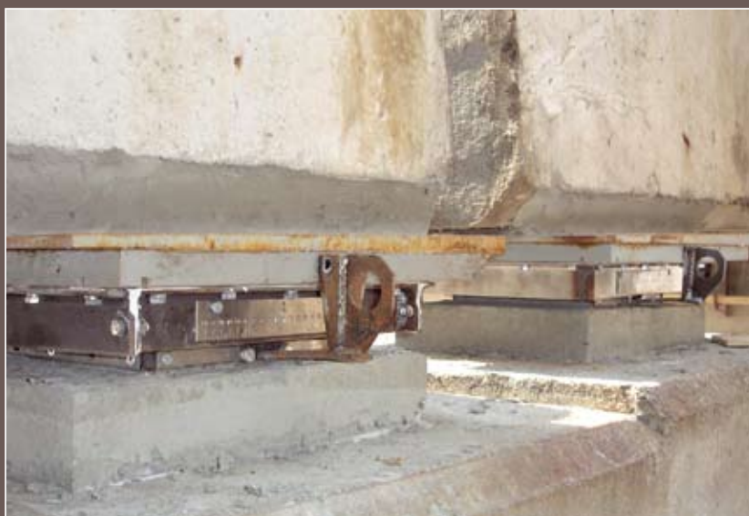
Шаровые сегментные опорные части, установленные взамен резиновых опорных частей
