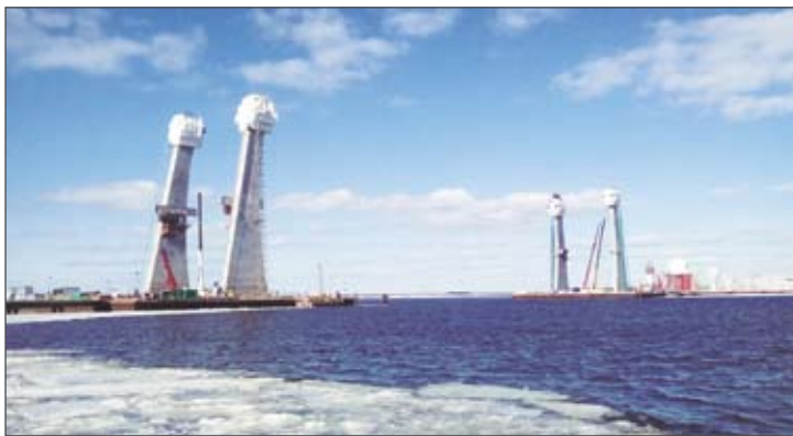
Возведение пилонов моста через Корабельный фарватер
