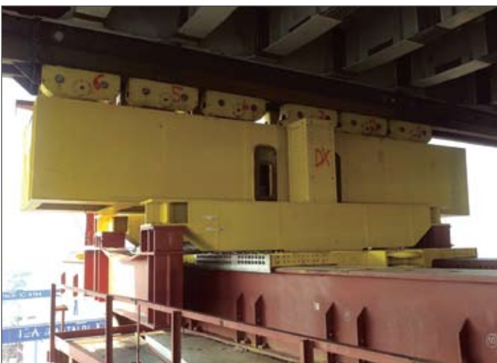
Устройство для надвигки двухъярусной фермы
