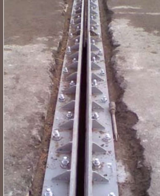
Крепление окаймлений деформационного шва химическими анкерами
