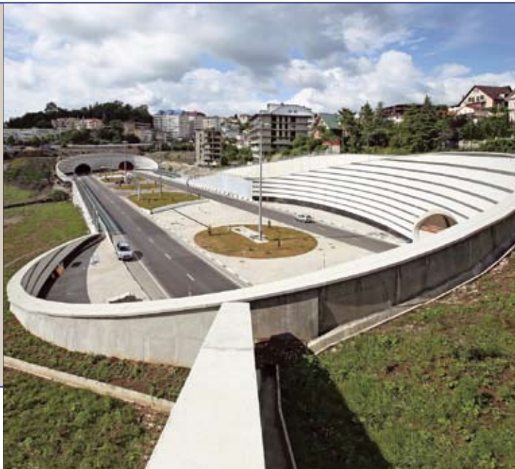
Транспортный тоннель олимпийского Сочи
