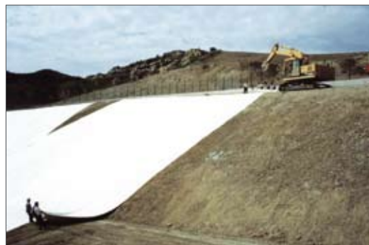
Рис. 3. Устройство откосного дренажа
