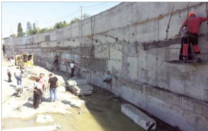
Строительство удерживающих противооползневых сооружений на Дублере Курортного проспекта
