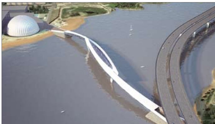
Санкт-Петербург. Яхтенный мост
