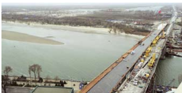
Ростов-на-Дону. Строительные работы по реконструкции Ворошиловского моста
