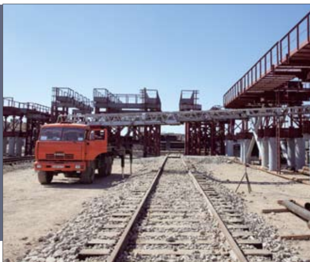
Стапель под сборку арок на Технологической площадке «Керчь»
