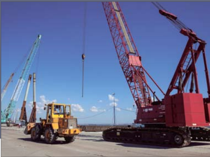
Работа на стройплощадке
