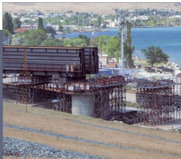
Укрупнение пролетных строений железнодорожного моста
