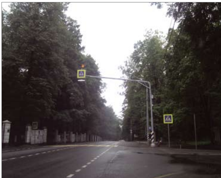
Федеральная автомобильная дорога Ильинское шоссе
