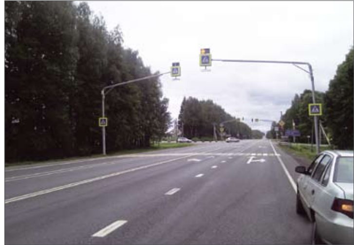
Федеральная автомобильная дорога А-108 «Московское большое кольцо», Брестско-Минское шоссе.
