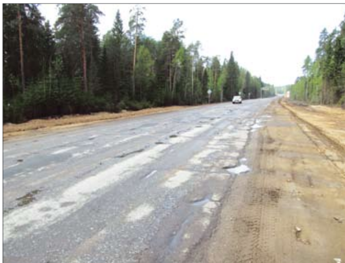
Рис. 2. Общий вид опытного участка до ремонта
