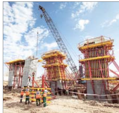
Устройство опалубки и армирование ригеля опоры №7 моста через р. Самару
