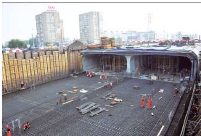
Армирование плиты проезжей части путепровода тоннельного типа на пересечении Московского шоссе и проспекта Кирова
