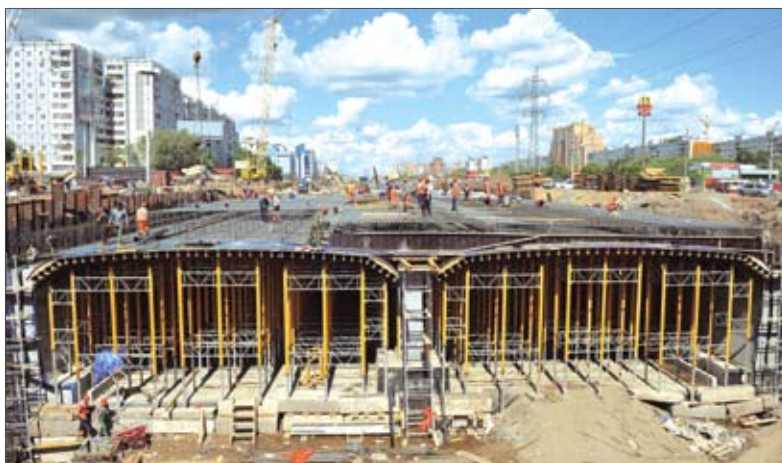
Опалубка свода перекрытия путепровода тоннельного типа на пересечении Московского шоссе и проспекта Кирова.
