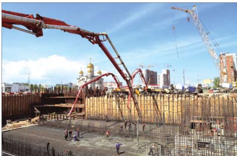
Армирование свода перекрытия путепровода тоннельного типа на пересечении Московского шоссе и проспекта Кирова
