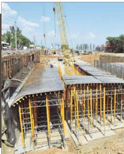
Монтаж опалубки перекрытия свода путепровода на пересечении Московского и Ракитовского шоссе
