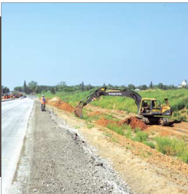
Строительство автомобильной дороги Волжский — аэропорт «Курумоч»
