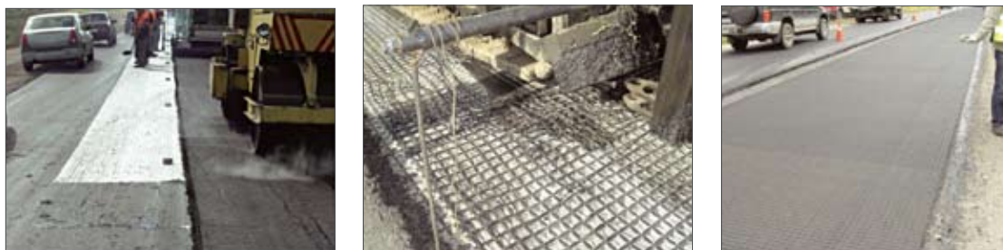
Рис. 3. Укладка геосинтетических материалов на экспериментальном участке
