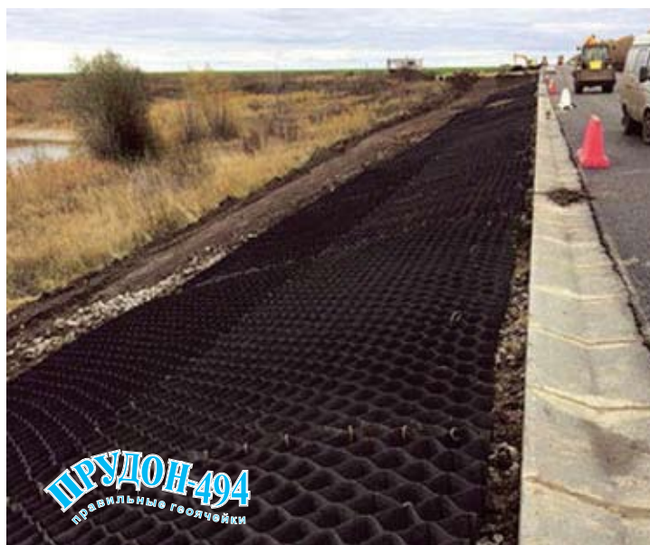
Откосы автодороги М-4 «Дон»
