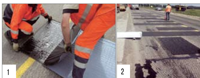
Рис. 13. Геокompозит HaTelit® BL (1 – снятие защитной пленки; 2 – заделка трещин)
