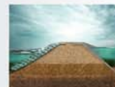
Берегоукрепление, армирование насыпей
