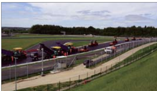
Укладка верхнего слоя покрытия в районе гравийных зон вылета, июль 2012
