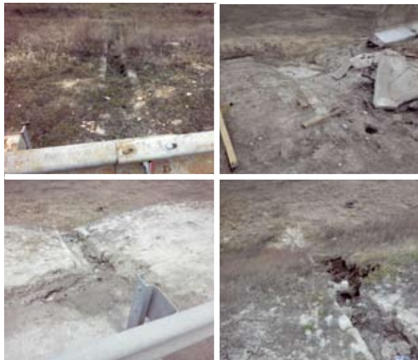
Рис. 5. Состояние телескопических лотков
