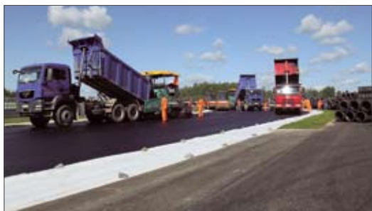
Укладка верхнего слоя покрытия в районе естественных трибун, июль 2012
