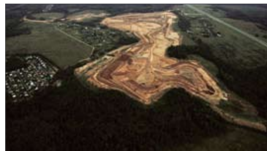
Трек, устройство земляного полотна, сентябрь 2010
