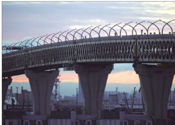
Двухъярусный мост через Морской канал
