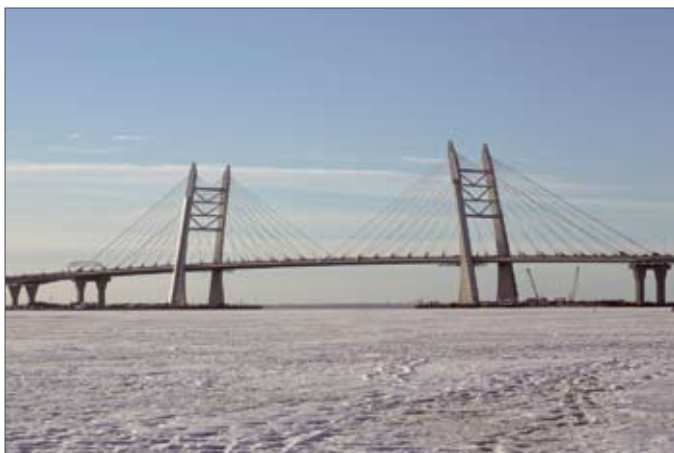
Вантовый мост через Корабельный фарватер
