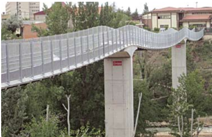
Вид на мост с пролетными строениями, опирающимися на углепластиковые струны
