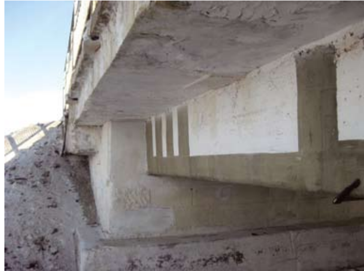
Усиление пролетного строения моста у г. Татищево Саратовской области наклейкой углеродных лент
