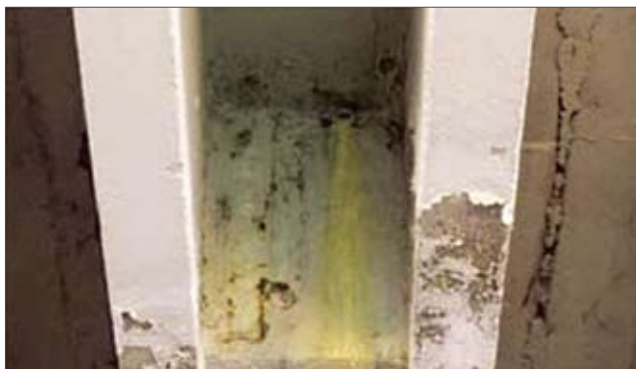
Разрушение и коррозия конструкции пролётного строения из-за протечек
