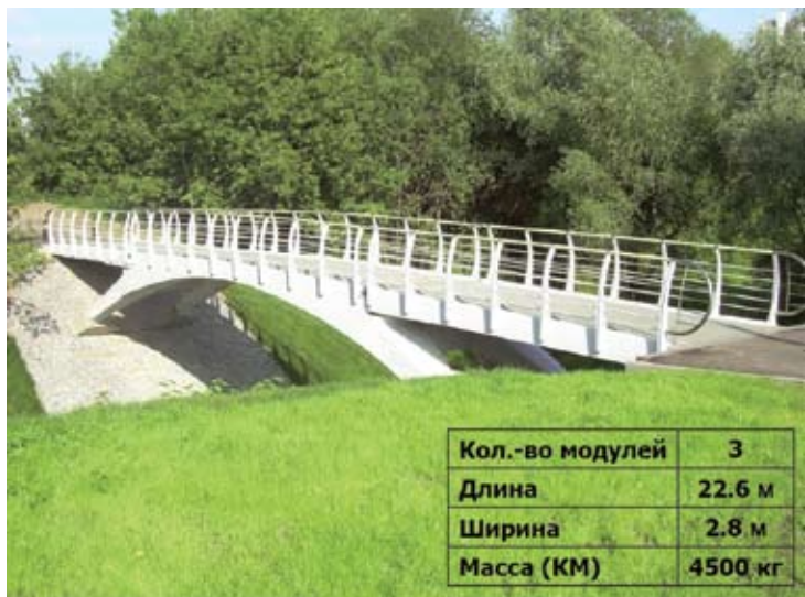
Арочный мост из полимерного композитного материала
