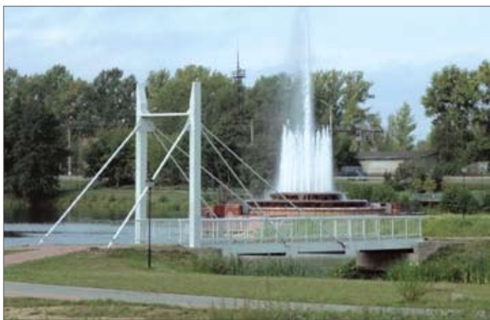
Однопильный пешеходный мост с применением композиционных материалов
