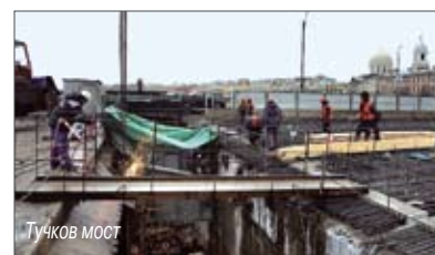
Мост в створе Яхтенной улицы
