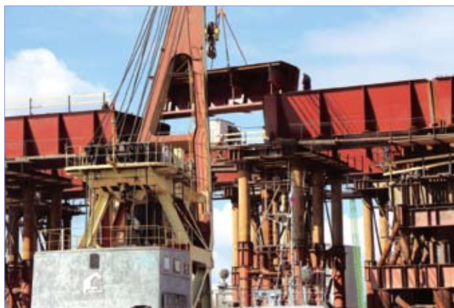
Строительство моста через остров Серный
