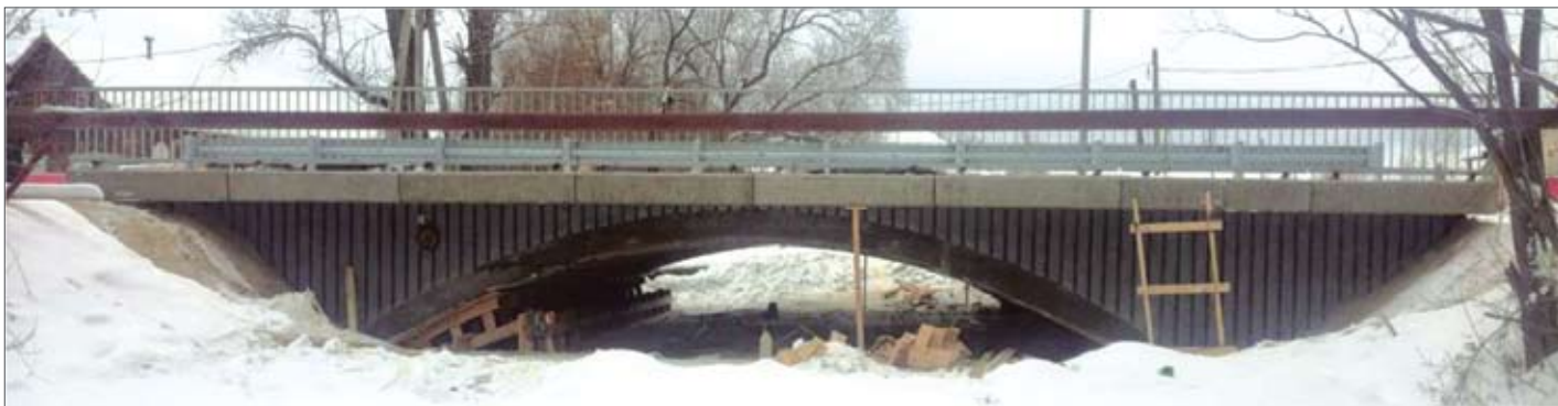
Мост через ручей Соловей в пос. Языково Карсунского района Ульяновской обл
