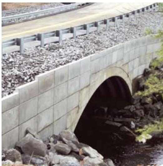
Мост с несущими элементами в виде фибропластиковых арочных труб, заполненных бетоном
