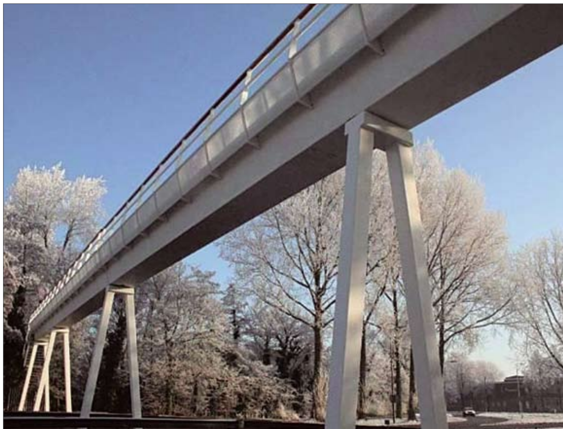
Пешеходный мост с композитным пролетным строением
