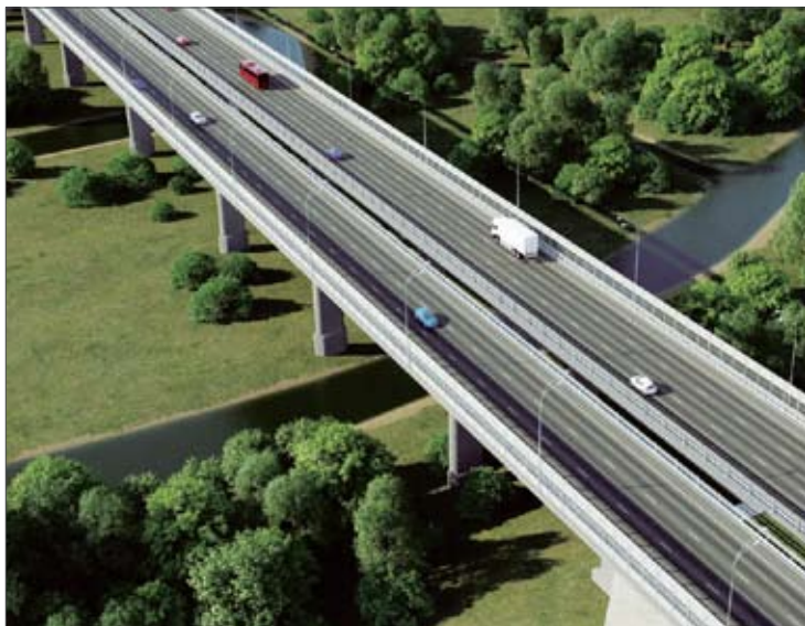
Скоростная платная автомобильная дорога «Москва – Санкт-Петербург»
