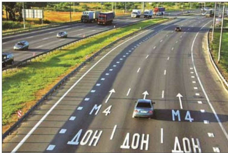
Автомобильная дорога М-4 «Дон»
