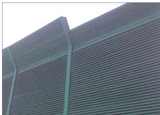
Автомобильная дорога М 4 «Дон»: шумозащитный экран с применением композитных материалов. Год строительства 1998
