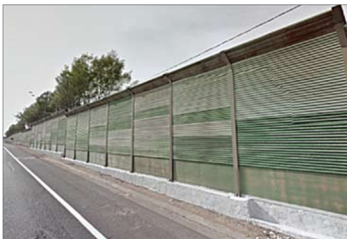
Автомобильная дорога М1 «Беларусь»: шумозащитный экран с применением композитных материалов. Построен в 2003 г.
