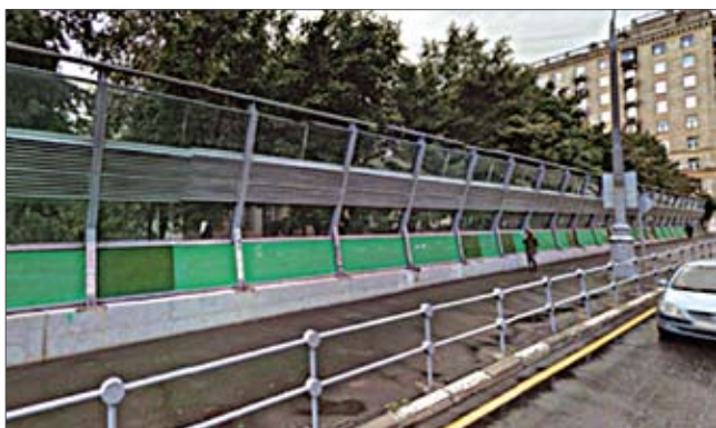
Москва, ул. Беговая: шумозащитный экран с применением композитных материалов. Год строительства 2002
