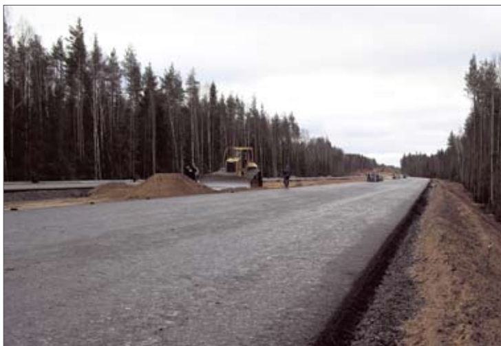
ЗСД: 3-я очередь строительства
