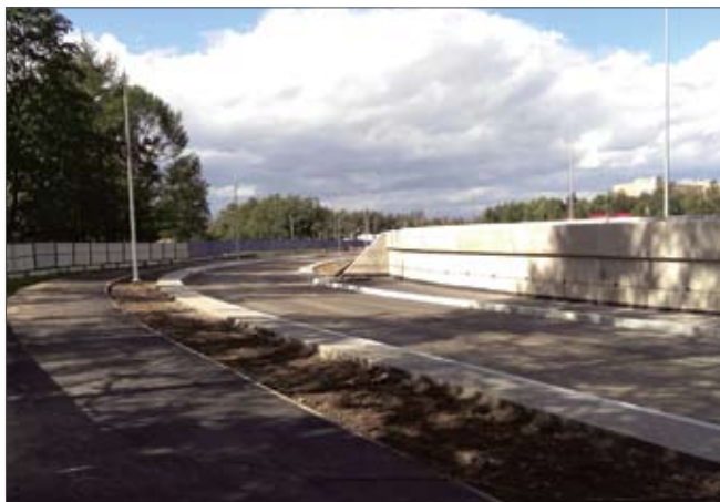
Строительство транспортной развязки на пересечении Пискаревского пр. и пр.Непокоренных
