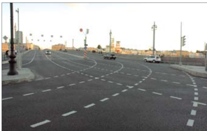
Площадь Трезини. Текущий ремонт
