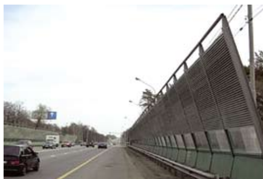
Автомобильная дорога М7 «Волга»: шумозащитный экран с применением композитных материалов. Год строительства 2003
