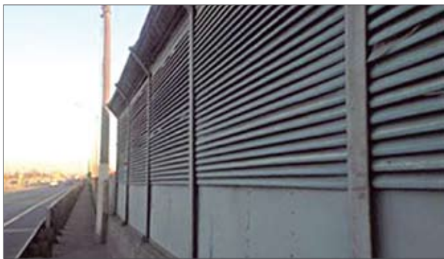
Автомобильная дорога М 10 «Россия»: шумозащитный экран с применением композитных материалов. Год строительства 2001
