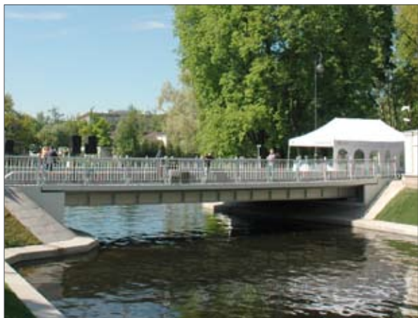
Каменноостровский мост: капитальный ремонт
