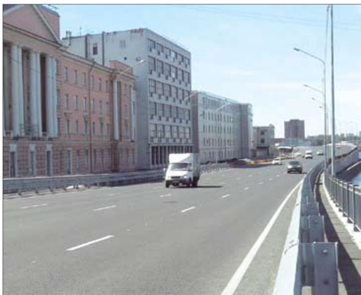
Строительство проезда по южному берегу Обводного канала от Глухоозерского шоссе до пр. Обуховской Обороны с мостом через ковш Обводного канала
