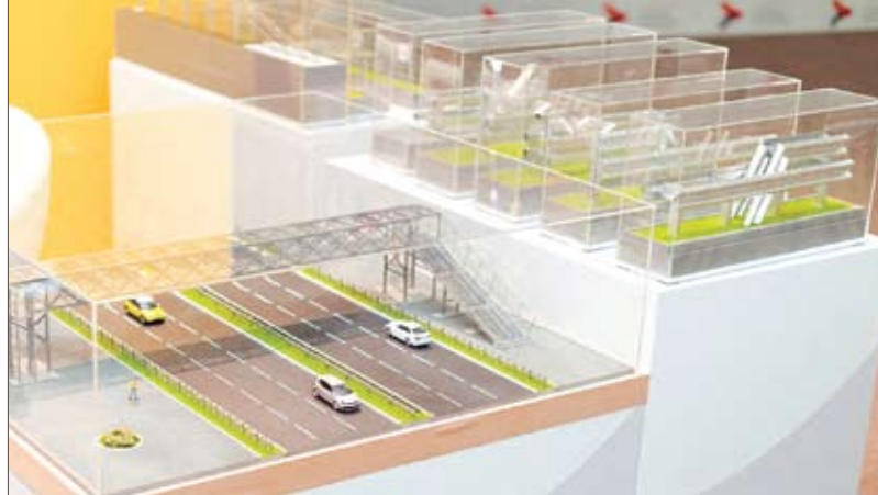
Макет модульного пешеходного надземного перехода
