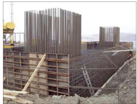
Рис. 7. Арматурный каркас ростверка опоры эстакады на полуострове Назимова
