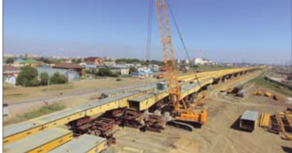
Монтаж пролетного строения. Железнодорожная эстакада. г. Астана
