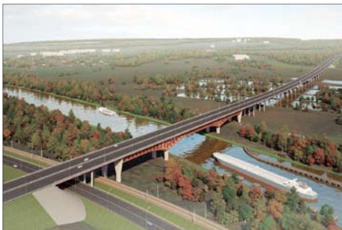
Мостовой переход через канал им. Москвы
