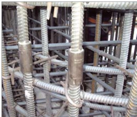
Рис. 10. Стыки фирмы Lenton в арматурном каркасе опоры
