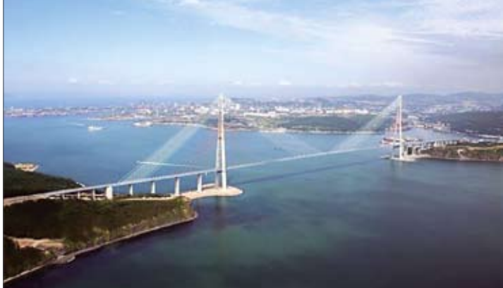
Рис. 1. Общий вид моста на о. Русский
