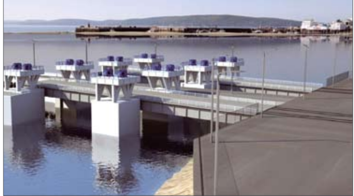
Подъемно-переходные мосты, порт Курык (визуализация)
