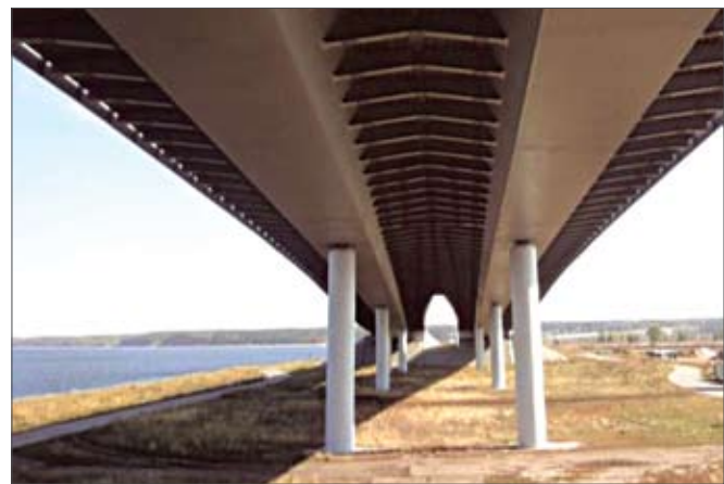
Состояние бетонных и металлических конструкций «Президентского моста» в 2016 г.
