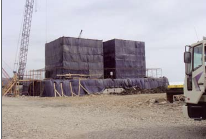
Рис. 3. Общий вид экспериментального ростверка временной опоры 8, сооруженного из самоуплотняющейся бетонной смеси
