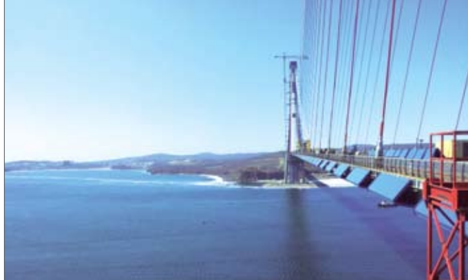
Рис. 2. Общий вид моста в процессе монтажа балки жесткости
