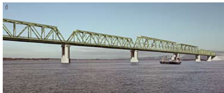
Мостовой переход через р. Амур в Еврейской автономной области: а — построенная часть; б — визуализация объекта
