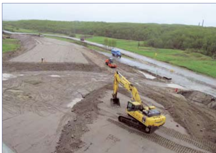
На строительстве Мурманского транспортного узла
