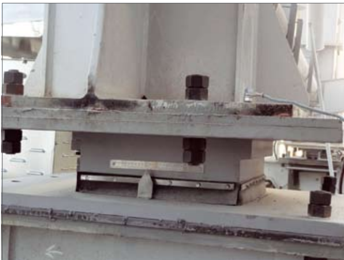
Опорная часть под раздвижной крышей стадиона «Зенит-Арена»
