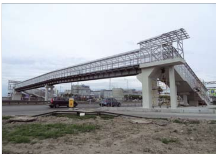
Пешеходный мост на Пулковском шоссе в Санкт-Петербурге
