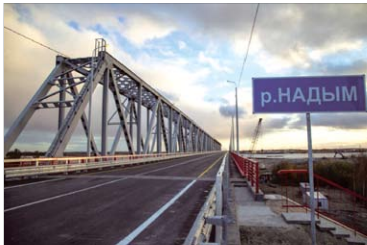
Мостовой переход через р. Надым
