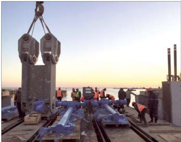
На строительстве подъемно-переходных мостов, порт Курык
