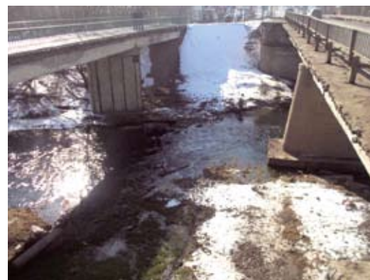
Рис. 7. Вид моста через Плаву
