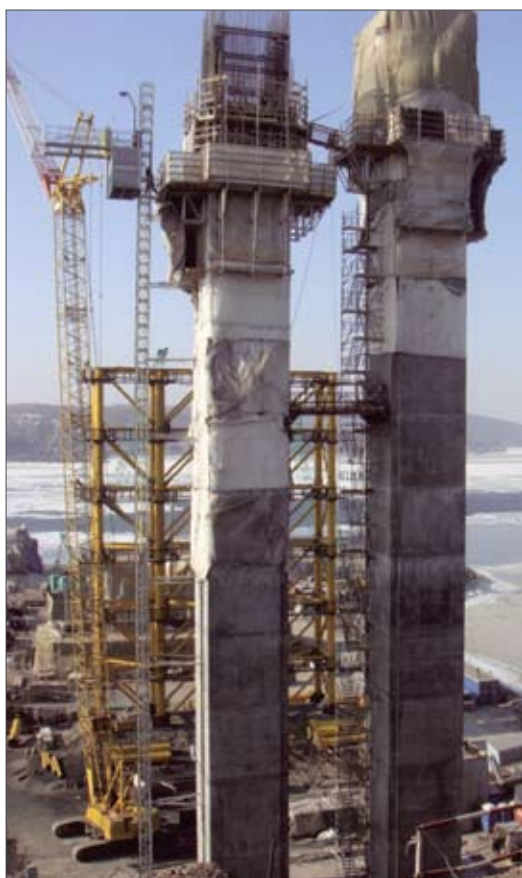
Рис. 11. Общий вид опоры М5 (высота 65 м)
