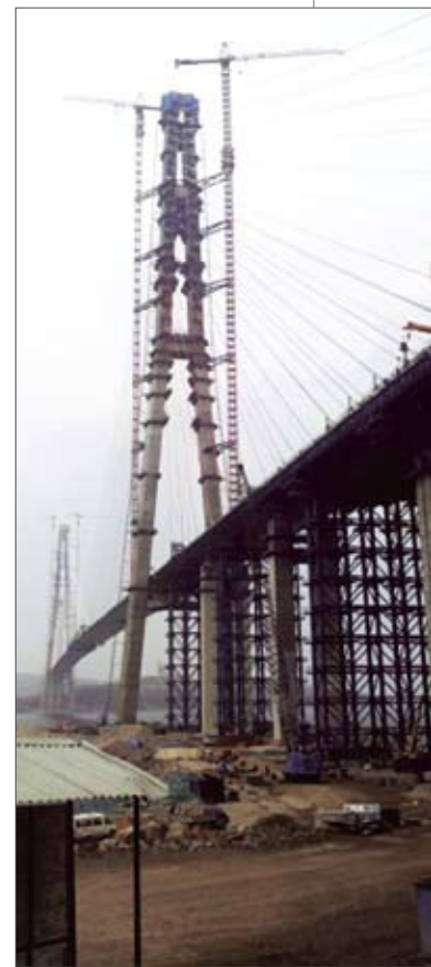
Рис. 12. Пилон М7 моста в процессе строительства
