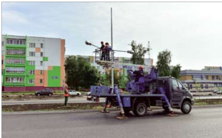
г. Набережные Челны, ремонт Московского проспекта
