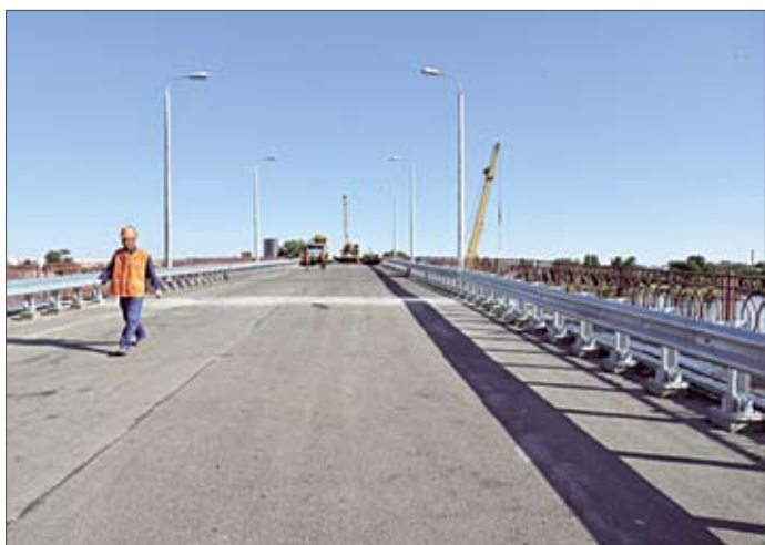
Мост в створе ул. Соликамской через р. Кривая Болда, г. Астрахань, до и после ремонтных работ
