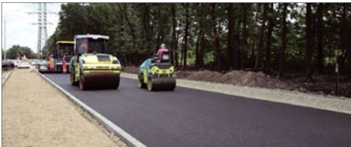
Ремонт дорог в Краснодарском крае
