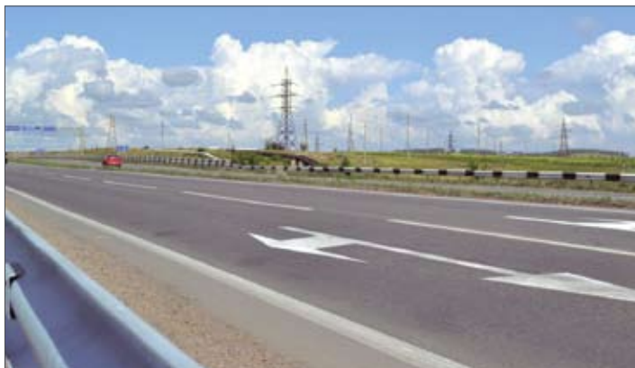
Участок дороги Р-257 Красноярск – Енисейск после реконструкции
