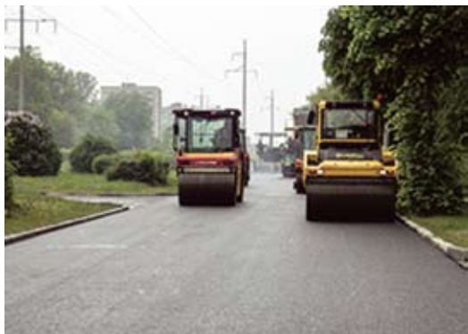
Ремонт дорог в Рязанской области
