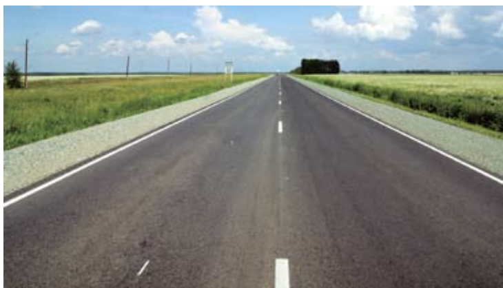
г. Барнаул, автомобильная дорога Белоярск—Заринск до и после ремонта
