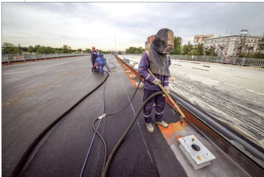
Строительство транспортной развязки в Балашихе на федеральной трассе М-7 «Волга»
