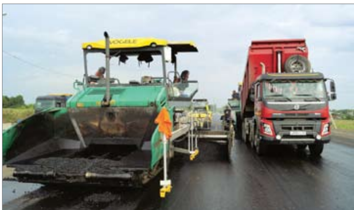
Реконструкция км 241— км 245 федеральной трассы М-5 «Урал» в Рязанской области
