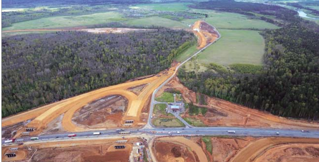
Строительство транспортной развязки на 198 км федеральной трассы М-10
